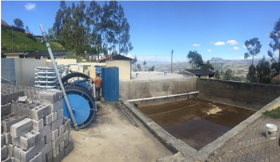
Ilustración 16. Zona de emplazamiento del floculador
