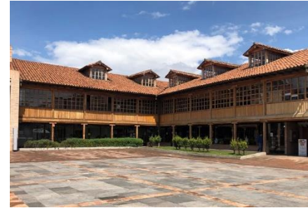
Figura 28 Fachada Nota: Realizado propio (Jennifer Méndez, 2022).
