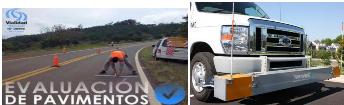
Figura 4: Evaluación funcional de pavimentos con determinación de deterioro superficial, regularidad superficial, resistencia al deslizamiento y medición del ruido.
