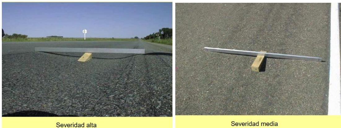
Figura 7: Ahuellamiento según nivel de severidad
