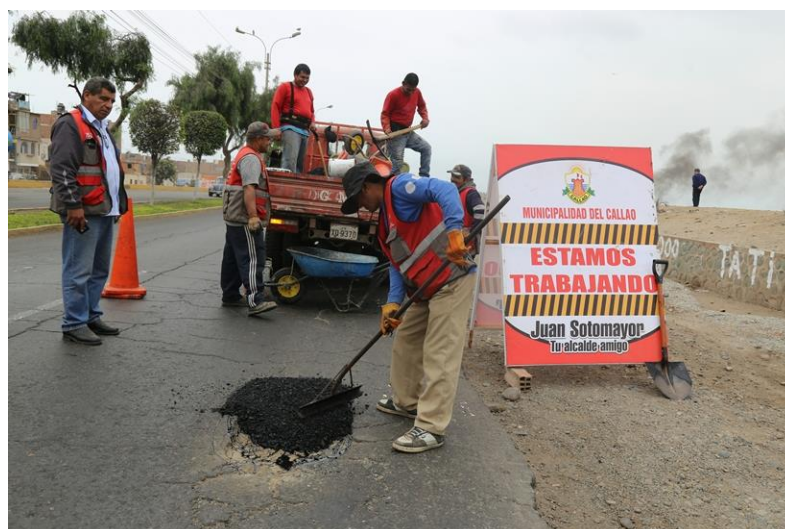
Figura 12: Exploración de materiales en el pavimento
