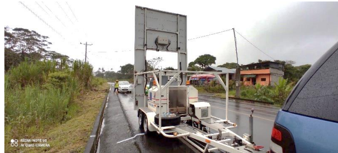
Figura 13: Toma de datos deflectométricos del pavimento con FWD
