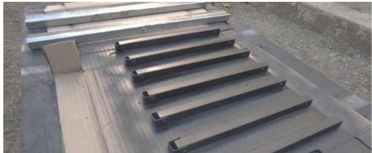
Figura 122. Colocación de pintura negra en elementos de acero
