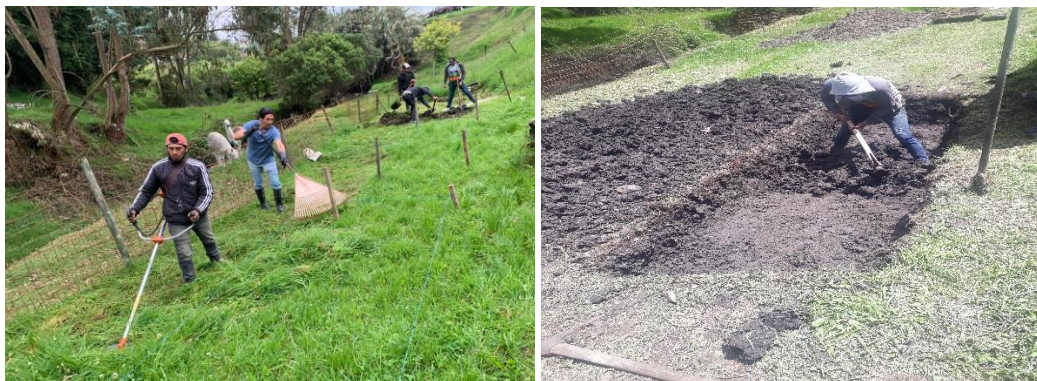
Figura 11. Limpieza del sitio de emplazamiento del proyecto. Fuente: Autores (2022).
