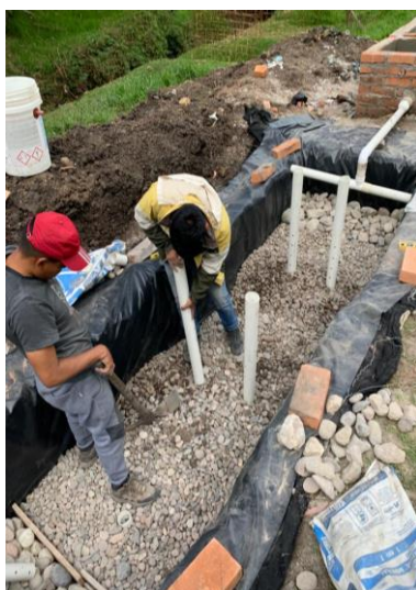
Figura 13. Colocación de tuberías de aireación. Fuente: Autores (2022).
