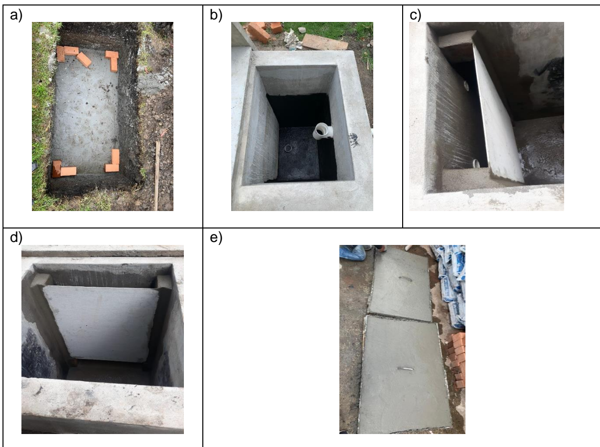
Figura 36. Elaboración de tratamiento primario: a) Replanteo de hormigón, b) Fosa séptica enlucida e impermeabilizada, c) y d) Deflector vertical y e) Tapas de hormigón.
