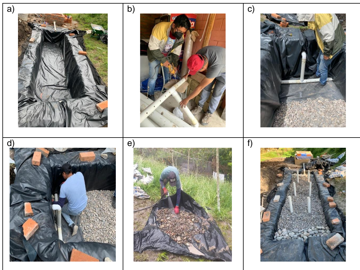
Figura 37. Elaboración de tratamiento secundario: a) Colocación de geomembrana, b) Perforación de tuberías \varnothing=75 mm, c) Colocación de tubería de salida, d) Colocación de grava gruesa, e) Lavado de grava fina y f) HA sin plantas.
