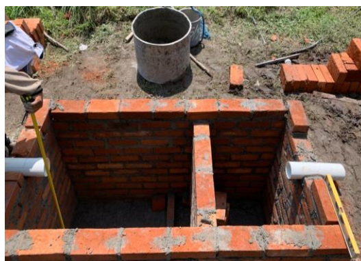
Figura 12. Colocación de ladrillos y tuberías de PVC. Fuente: Autores (2022).
