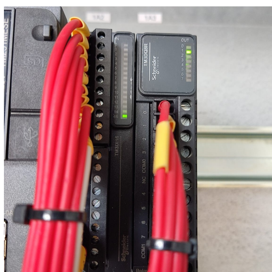
Figura C.5: RTU empleado en la micro-red.
