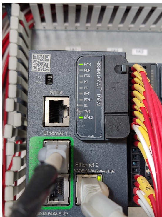
Figura C.4: PLC empleado en la micro-red.
