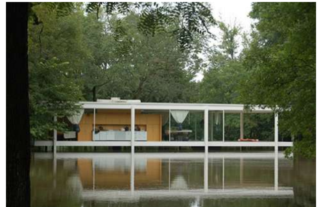
Figura 38. Desbordamiento del río Fox.
