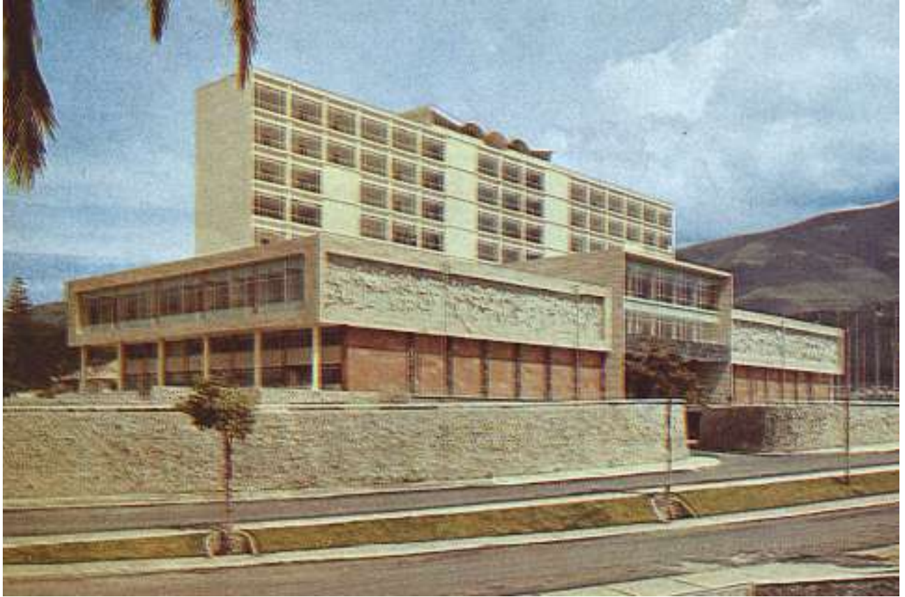
Figura 06. Edificio del Palacio Legislativo.
