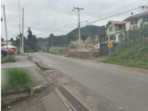
Fotografía 2-9: Tramo de Panamericana que converge en la intersección C
