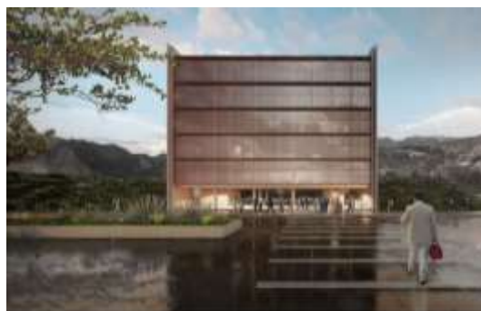
Ilustración 2.16: Edificio de Oficinas; Fuente: Equipo consultor arquitectónico
