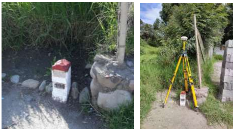
Ilustración 3.4 Hitos F-3 y BM-2 para levantamiento topográfico
