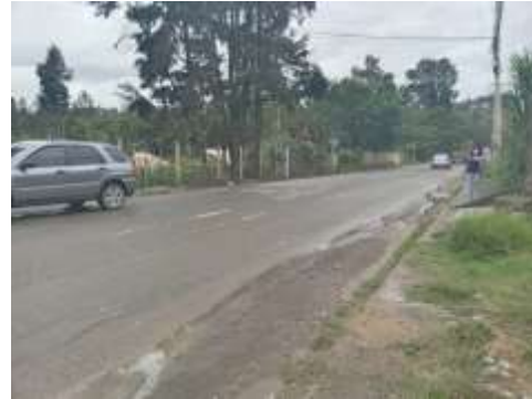
Fotografía 2-10: Tramo de Panamericana Norte que converge en la intersección C
