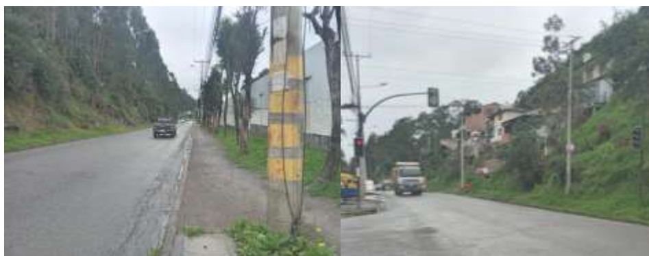
Fotografía 2-13: Tramo de Panamericana que converge en la intersección D
