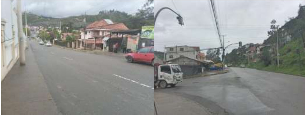
Fotografía 2-15: Tramo de puente Vía a Ucubamba S - N que converge en la intersección D Fotografía 2-16: Intersección D Panamericana Norte y Vía a Ucubamba
