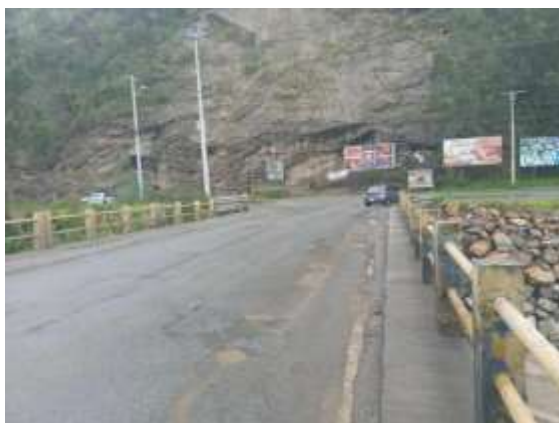
Fotografía 2-7: Tramo de puente Guangarcucho que converge en la intersección A
