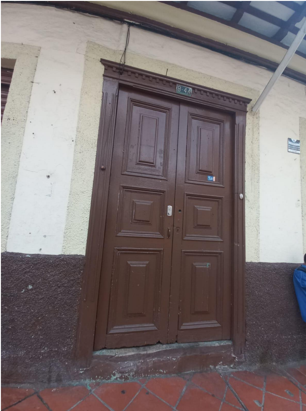
Figura 5: Puerta principal de la casa 8-44. Fotografía tomada en el espacio trabajado.
