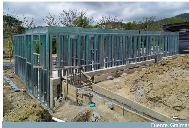
Figura 100: Vivienda en construcción con sistema Steel Framing, en Jama (Costa).
