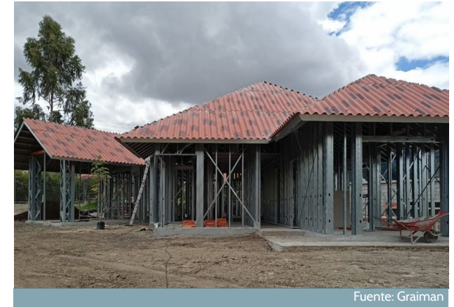
Figura 102: Vivienda construida con sistema Steel Framing, en Zamora (Amazonía).
