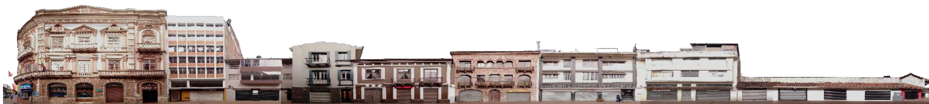
Figura 43. Plaza de las Flores - Tramo PA 3.
