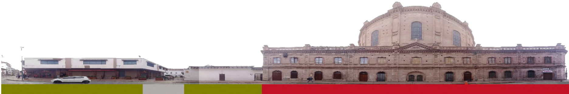
Figura 44. Plaza de las Flores - Tramo PA 4.
