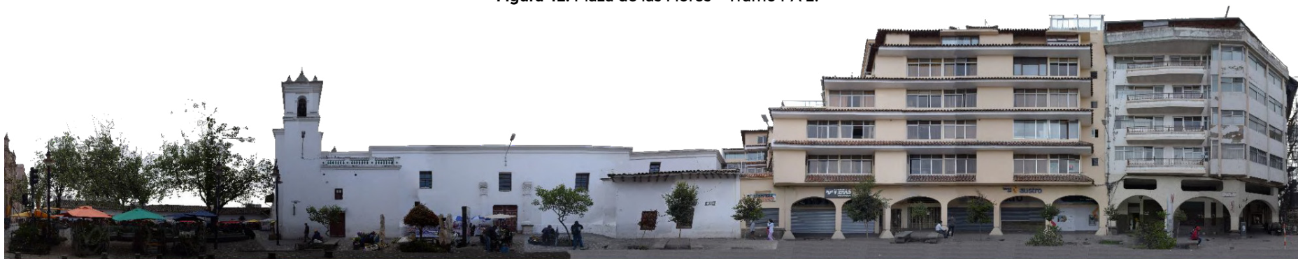
Figura 42. Plaza de las Flores - Tramo PA 2.
