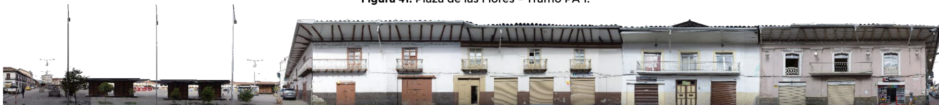
Figura 41. Plaza de las Flores - Tramo PA 1.
