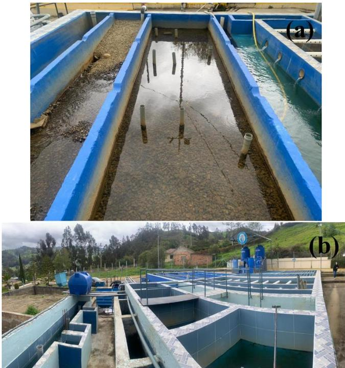
**Figura 6.** *Filtros: a) Prefiltros de grava b) Batería de filtros rápidos de arena*
