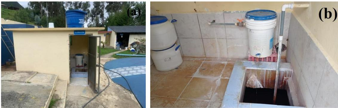
**Figura 7.** *Proceso de cloración: a) Cámara de cloración b) Dosificación por goteo*
