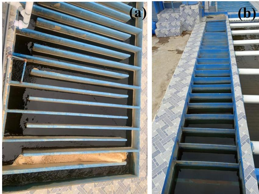
**Figura 4.** Floculadores hidráulicos: a) Floculador horizontal b) Floculador vertical
