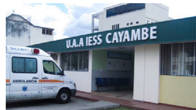
Fig. 19. Centros de Salud tipo A, Cayambe, Ecuador. Fuente: Misael Arias.
