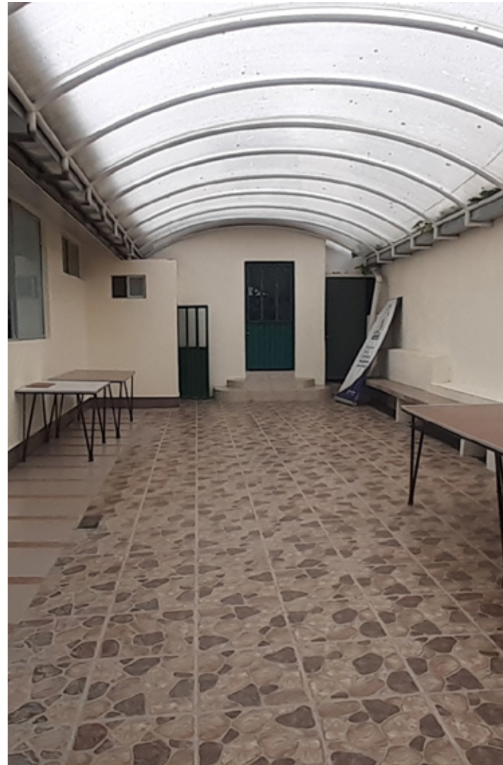
PR2 Salas adicionales Vista 1 . Fuente: propia.
