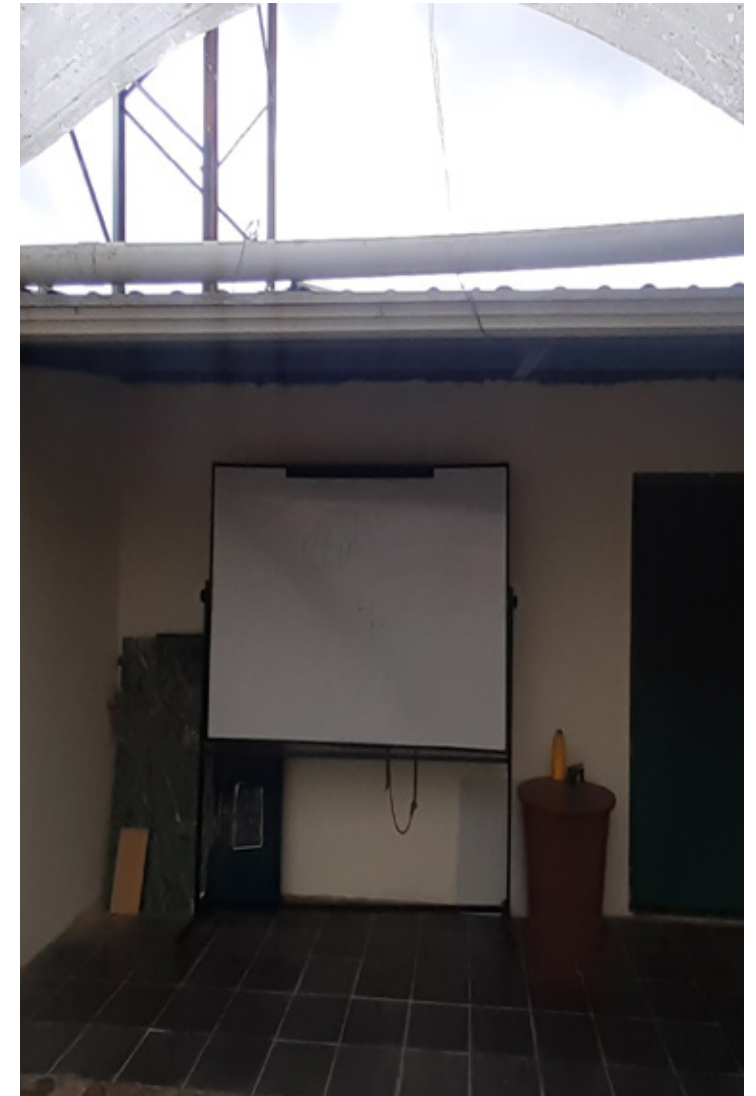
PR1 Salas adicionales Vista 2 . Fuente: propia.
