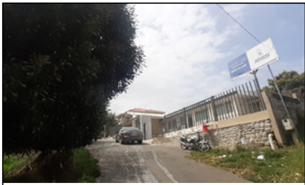
Vista 8. Vista norte del dispensario. Fuente: propia.
