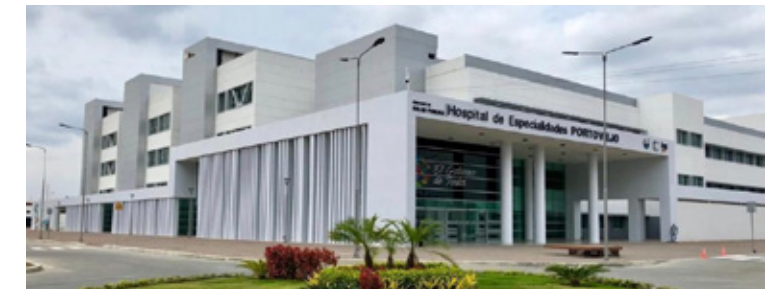
Fig. 13. Centro de salud de tercer nivel de atención. Fuente: Msp.
