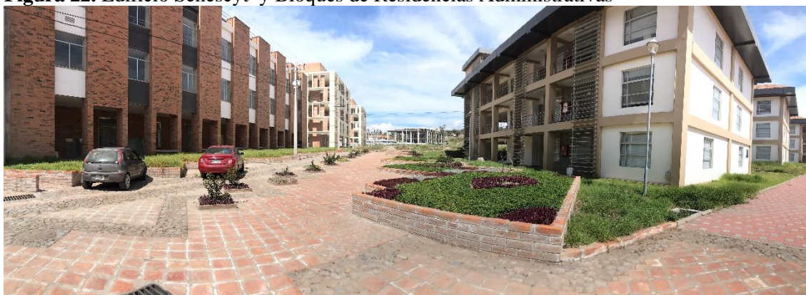
Figura 22. Edificio Senescyt y Bloques de Residencias Administrativas
