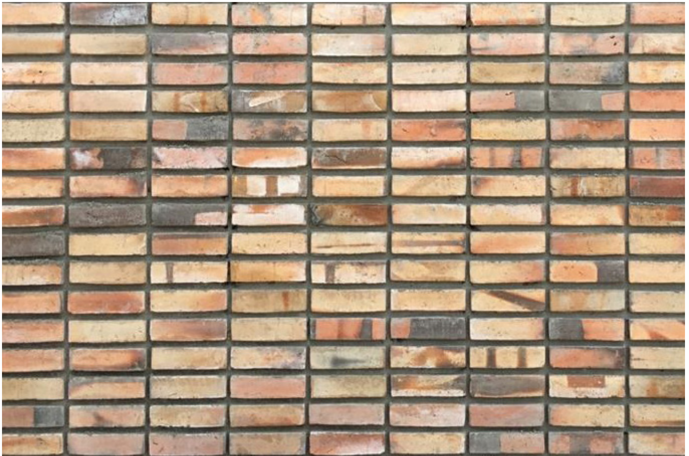
Figura 02. Aparejo de canto, Vivienda AA.
