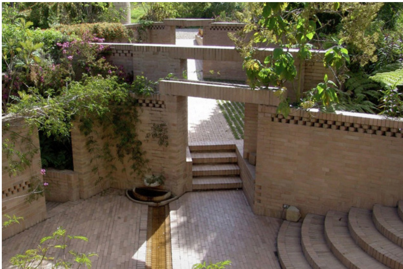
Figura 28. Ingreso Casa en Río Frío.
