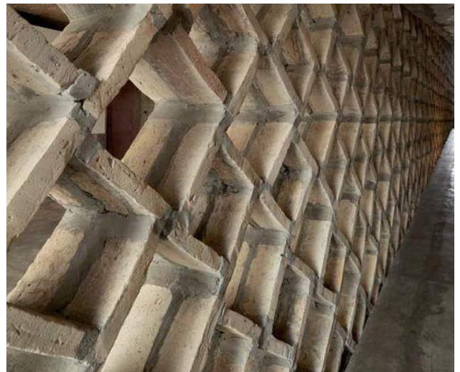
Figura 48. Armado de módulos para mampostería de la casa Abu & Font.
