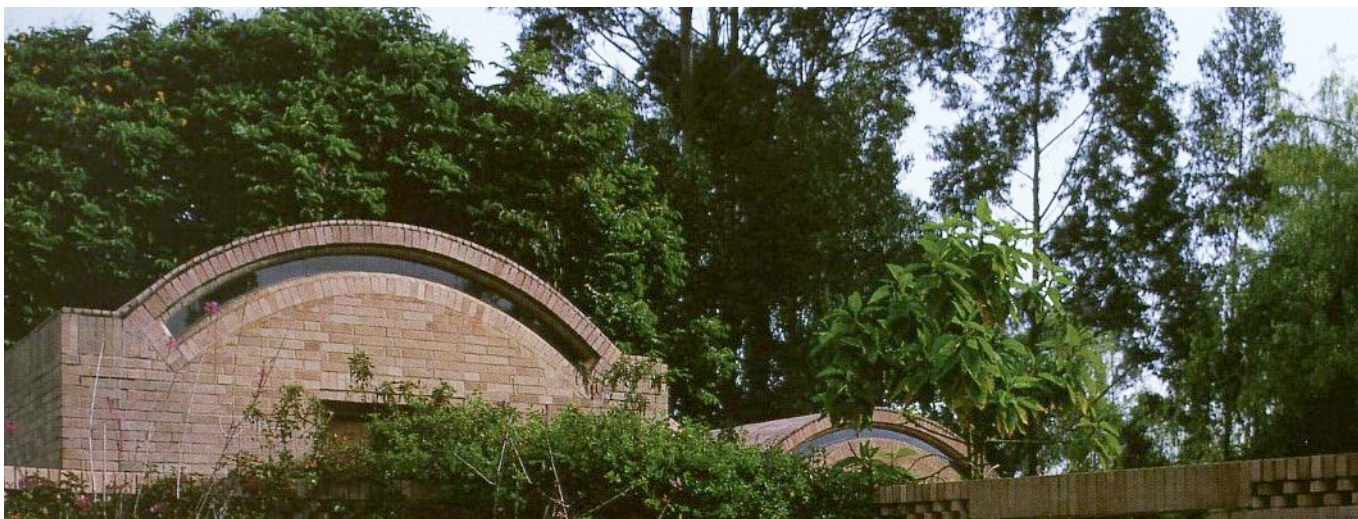
Figura 54. Exterior casa en Río Frío, cubierta abovedada.
