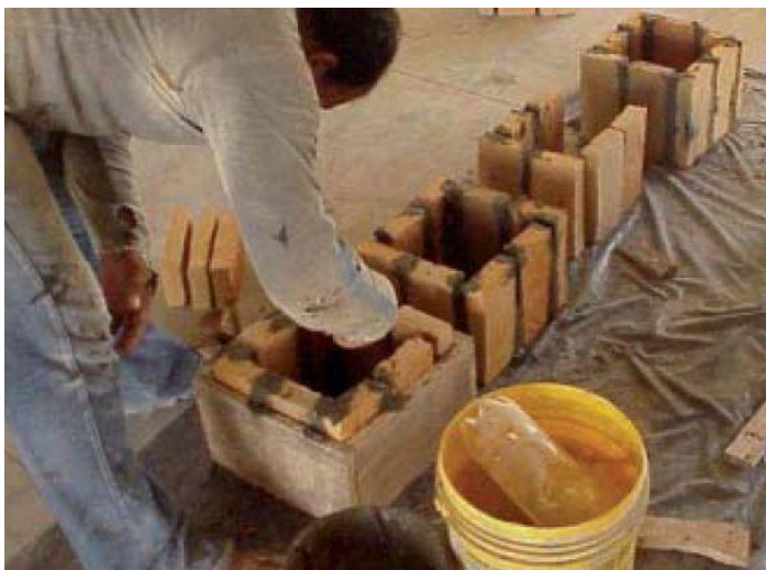
Figura 48. Armado de módulos para mampostería de la casa Abu & Font.
