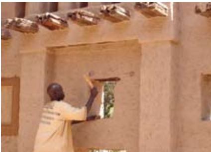
FIG 03. LA ARCILLOSA CONDICIÓN DE LA TIERRA UTILIZADA EN LAS ESTRUCTURAS PATRIMONIALES DE MALI, HACEN NECESARIA SU REPARACIÓN PERIÓDICA. ARCHIVO DEL AUTOR.
