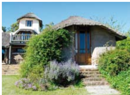
FIG. 7. ACTUALIZACIÓN DE LA TRADICIÓN CONSTRUCTIVA CON TIERRA REALIZADA POR LA ARQUITECTA CECILIA ALDERTON EN URUGUAY. (ARCHIVO DEL AUTOR)
