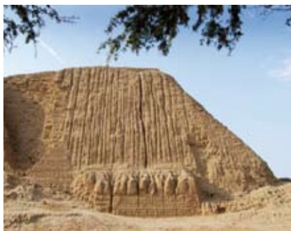
FIG. 4. NÚCLEO HECHO CON MILLONES DE ADOBES EN LA HUACA DEL SOL, TRUJILLO, PERÚ. (ARCHIVO DEL AUTOR)
