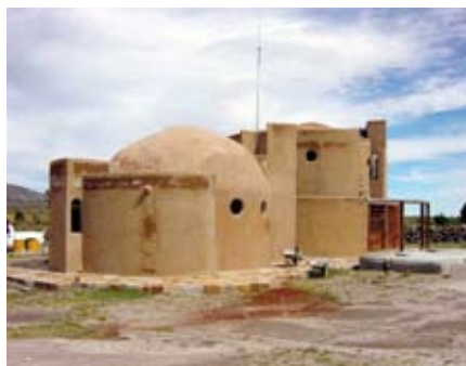
FIG. 2. LOS EDIFICIOS DE PLANTA CIRCULAR RESULTAN ESTABLES ANTE LA EVENTUALIDAD DE UN SISMO. SIERRA DE ÓRGANOS, ZACATECAS. (ARCHIVO DEL AUTOR)
