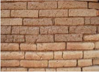
FIG. 1. A PESAR DE LA EVIDENTE DIFERENCIA EN LA FORMA Y COMPOSICIÓN DE LOS ADOBES DE ESTA VIVIENDA TRADICIONAL, LOS MUROS CONSERVAN SU CAPACIDAD DE CARGA. ICHAN, MICH. (ARCHIVO DEL AUTOR)
