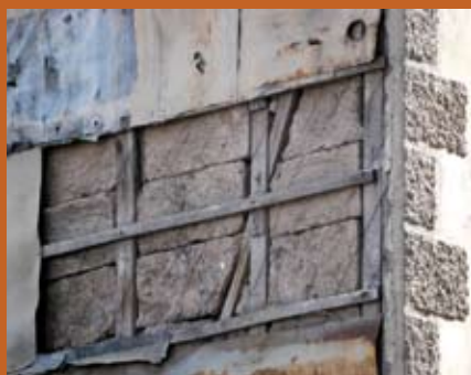
FIG. 4. ADOBES EN PANDERETA EN EL MURO DE COLINDANCIA DE UN EDIFICIO HISTÓRICO DE SANTIAGO DE CHILE. (ARCHIVO DEL AUTOR)
