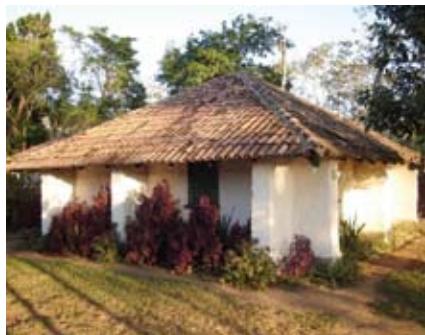
FIG. 5. REFUERZOS DE ESQUINA EN UNA VIVIENDA ANTISÍSMICA DE ADOBE REALIZADA POR LA ARQUITECTA DULCE MARÍA GUILLÉN EN LA PIÑERA, NICARAGUA. (ARCHIVO DEL AUTOR)
