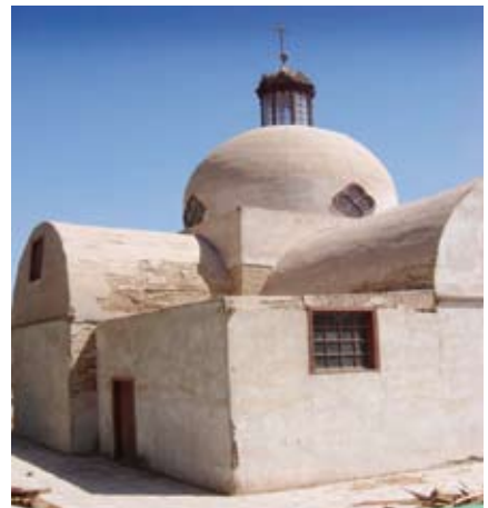
FIG. 6. LA FLEXIBILIDAD DE LA ESTRUCTURA PATRIMONIAL DE QUINCHA DE LA IGLESIA DE MATILLA, EN EL NORTE DE CHILE, PERMITIÓ QUE SOPORTARA FUERTES TERREMOTOS DESDE HACE DÉCADAS. (ARCHIVO DEL AUTOR)
