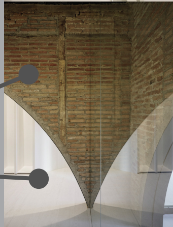
Figura 25: Fotografía espacio interior BABYDOG Fuente: Alca. (2017)
