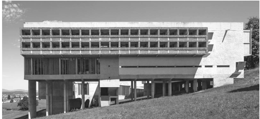
36 Convento de la Santa María de la Tourette, Francia.
