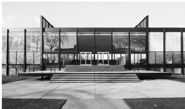
45 Fachada frontal del Crow Hall, Mies Van Der Rohe, 1950
