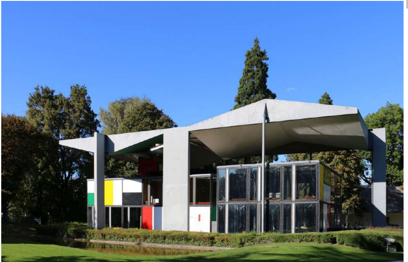
78. Vista acercamiento de la fachada 79. Vista fachada posterior
