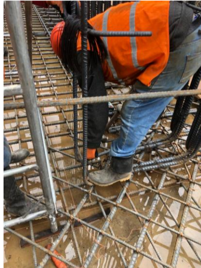
Foto 1: Trabajos de amare de hierro. Fuente: Propia.
