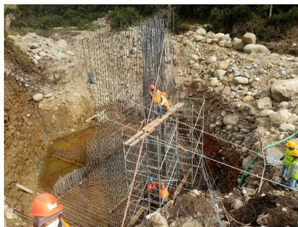
Foto 2: Trabajos en altura en armado de estructura. Fuente: Propia.
