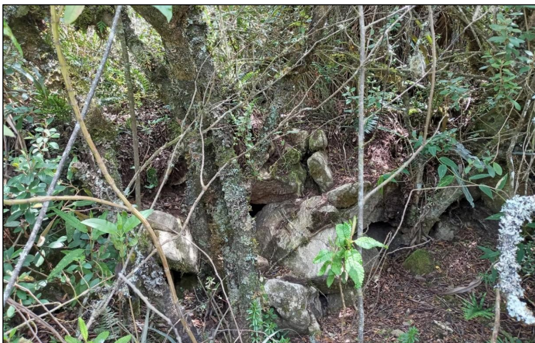
Imagen 64: Muro 3 Fuente: autoras Fecha: 18/02/2021 (loma “El Calvario”)
