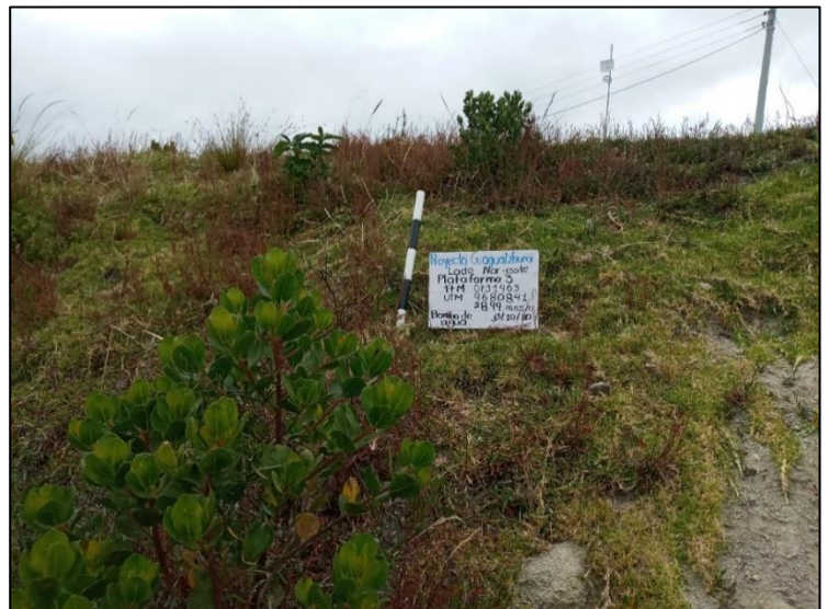
Imagen 22: Pendiente formada producto de la remoción de tierra para la construcción de la bomba de agua
