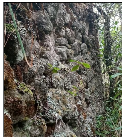
Vista de la parte externa del muro más alto
