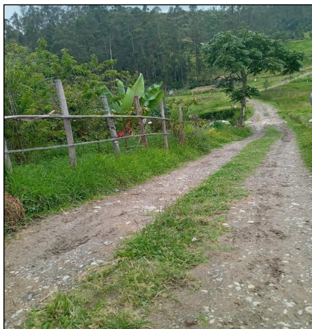
Imagen 55: Camino de ingreso al sector de Quituiña
