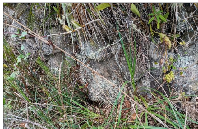
Acercamiento (detalle) del muro 2
