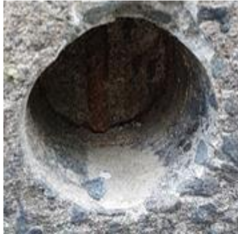
Gráfico 6 Perforación sin relleno, producto de la extracción de un núcleo.
