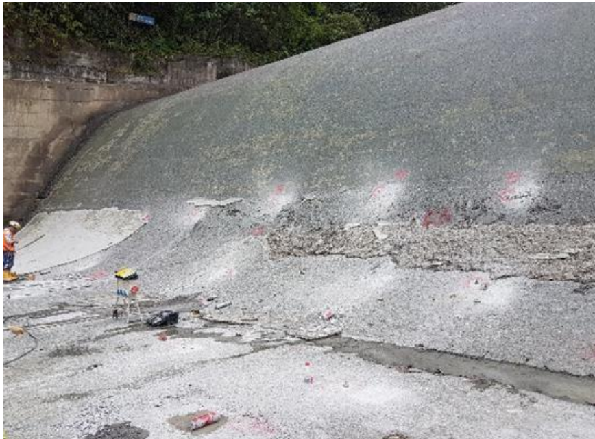
Gráfico 4 Efecto de la abrasión en la superficie del azud.
