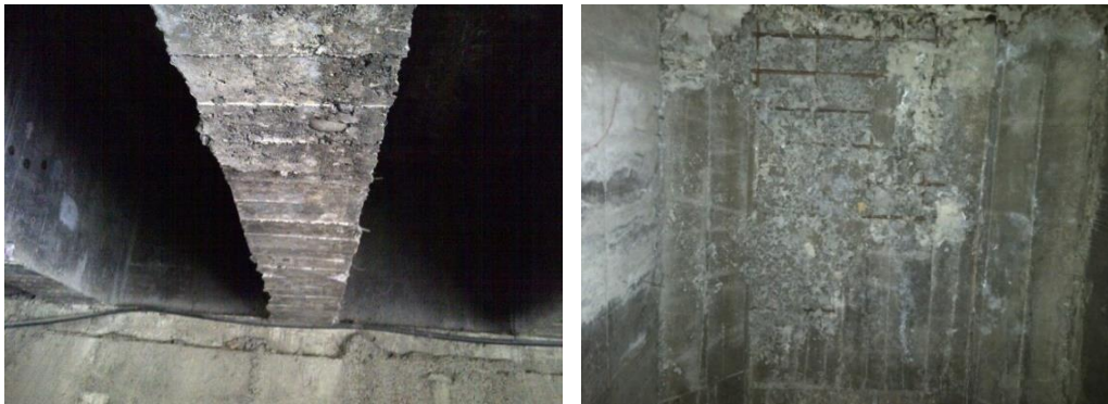
Gráfico 16 Ejemplos de pérdida de recubrimiento.
