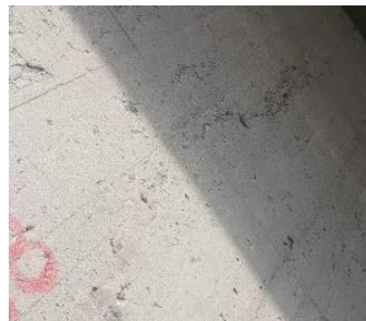
Gráfico 39 Proceso erosivo en los vertederos.
