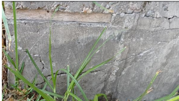
Gráfico 50 Grieta diagonal formada en una de las columnas del puente (Columna 1).
