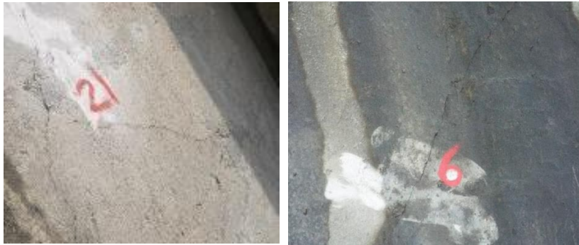
Gráfico 34 Fisura diagonal.
