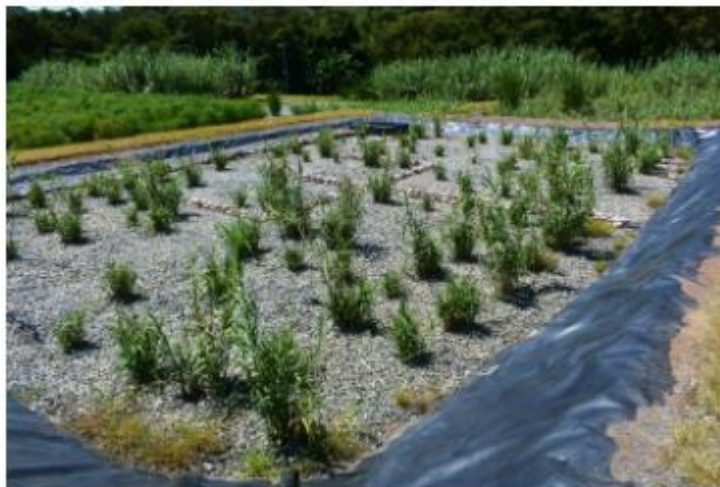
Ilustración 8 Ejemplo de Humedal Subsuperficial Horizontal
