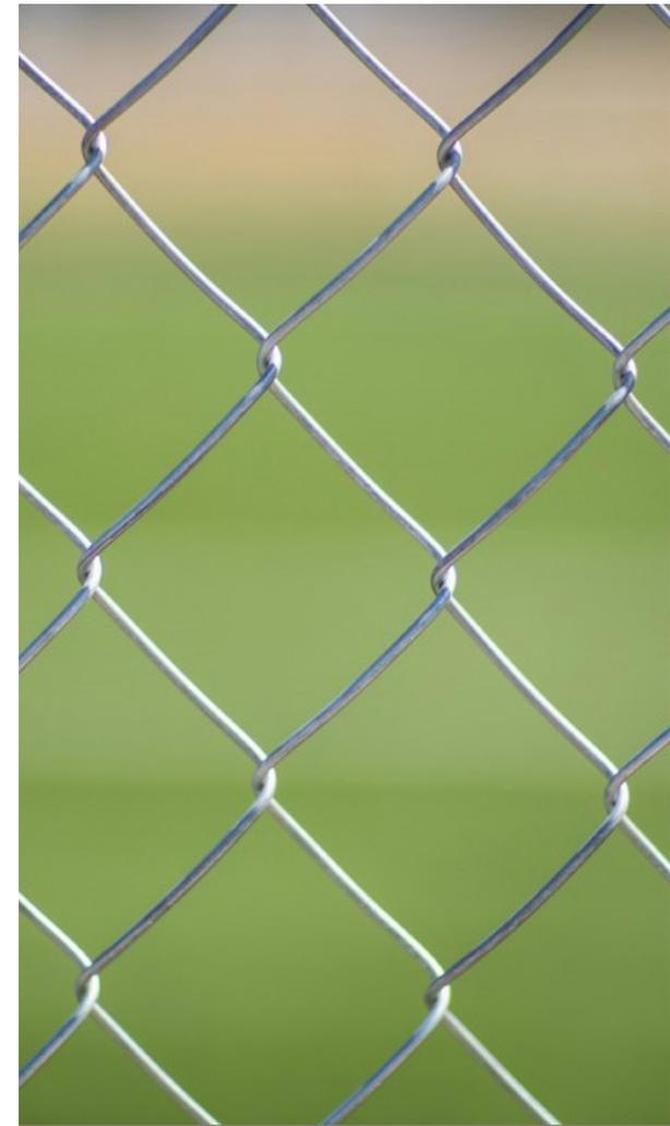
Imagen 046: Malla metálica de simple torsión.
