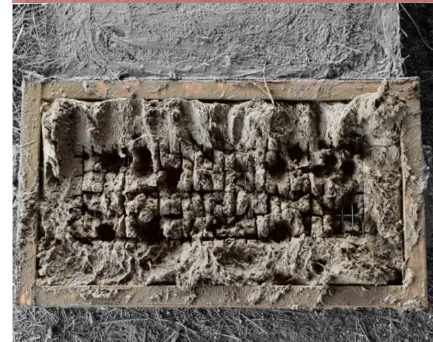
Imagen 088. Colocación de la última malla metálica de 34x14cm.
