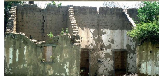
Imagen 027: Grietas en paredes de adobe y colapso de la cubierta.
