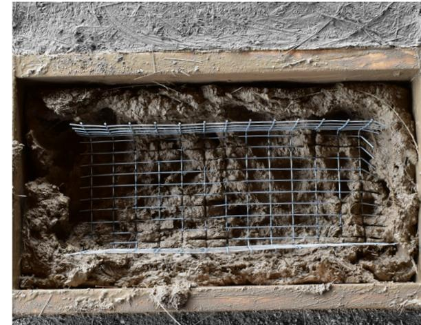
**Imagen 089.** Colocación de la malla metálica doblada en forma de U.
