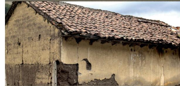
Imagen 026: Descascaramiento del mortero de enlucido y erosión del adobe a causa de la humedad.
