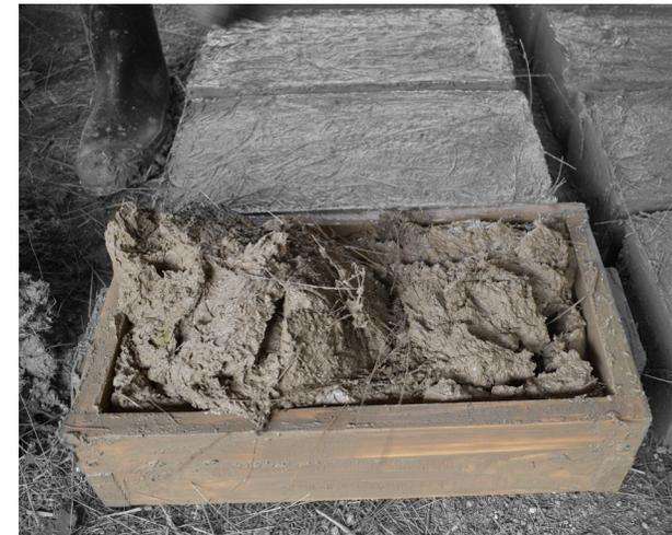
**Imagen 067.** Colocación del barro en el molde.
