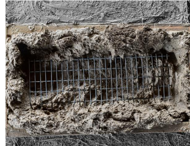
Imagen 087. Colocación de una de las tres mallas metálicas de 34x14cm.
