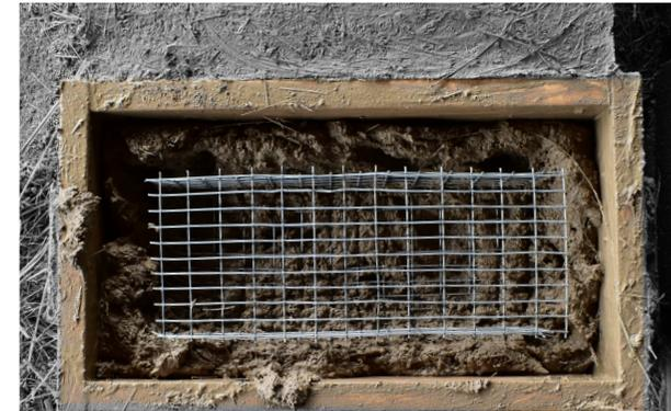
Imagen 091. Colocación de la malla metálica de 50x14cm sección rectangular.
