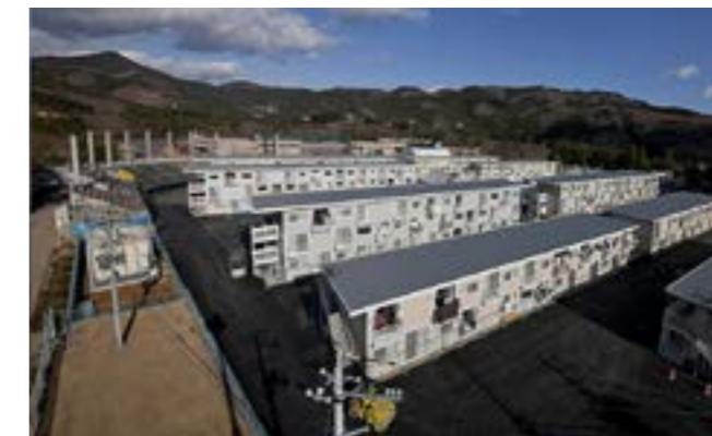
2.3 CONTENEDORES DE BARCO PARA LOS 'SIN TECHO' DEL TSUNAMI QUE ASOLÓ JAPÓN
