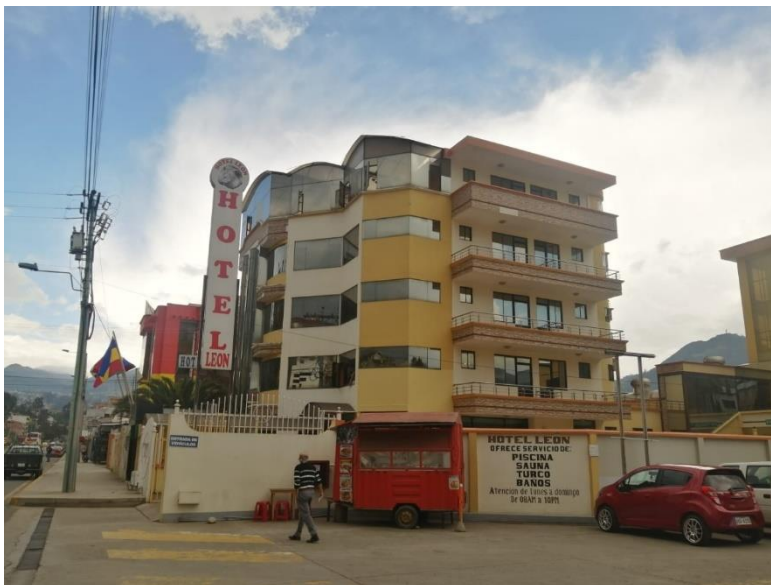
Fachada del Hotel León
