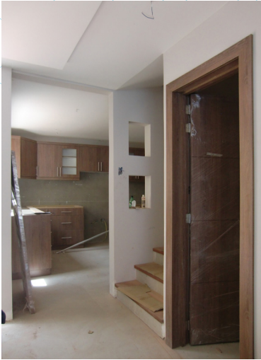
Vista de puertas.
