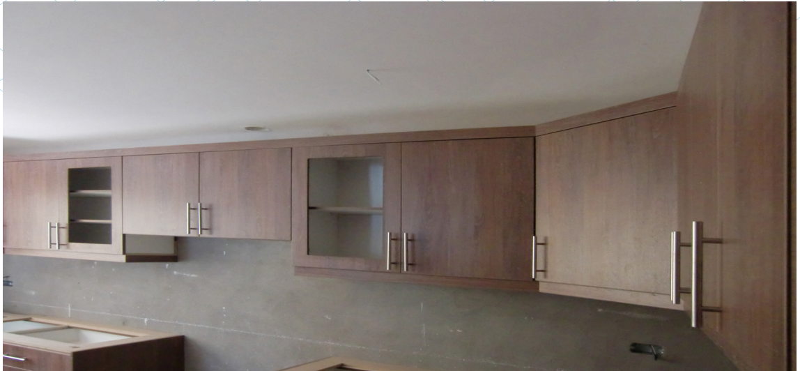
Vistas de espacios diagnosticados, mobiliario cocina.
