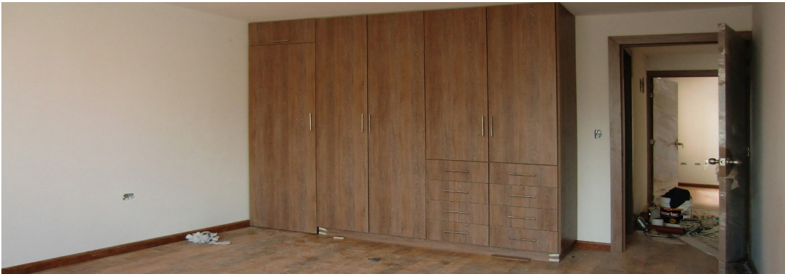
Vistas de espacios diagnosticados, habitaciones.
