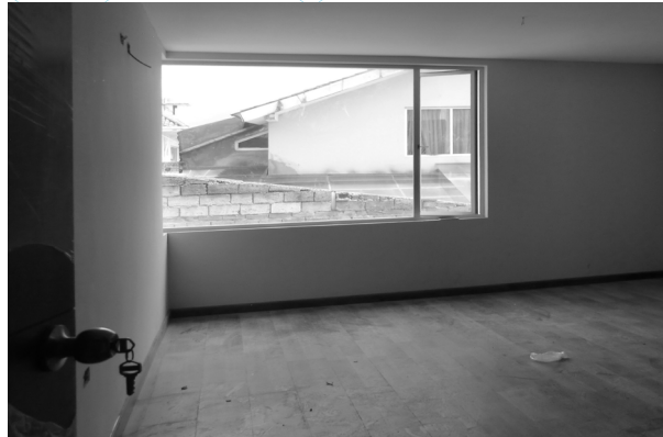
ESTADO ACTUAL Vivienda tipo aledaña
