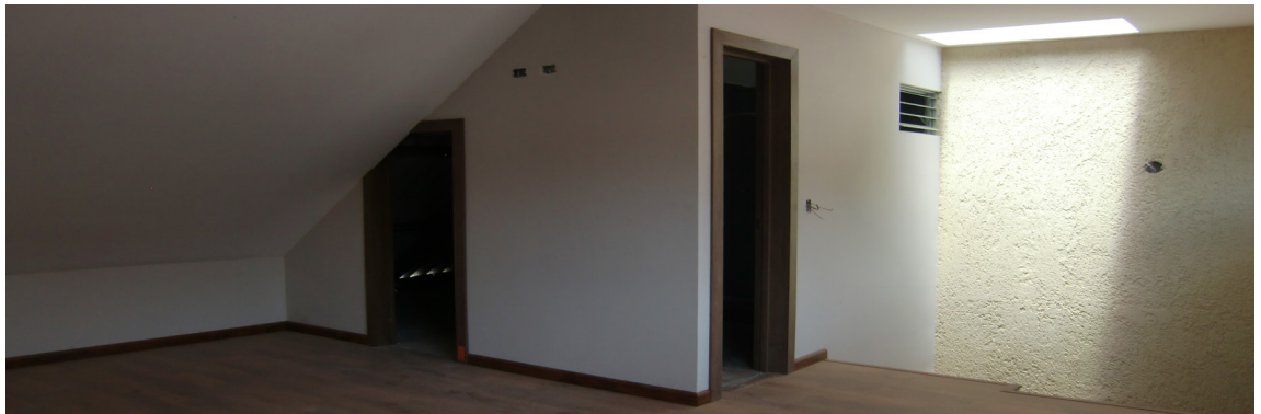
Vistas de espacios diagnosticados, puertas.
