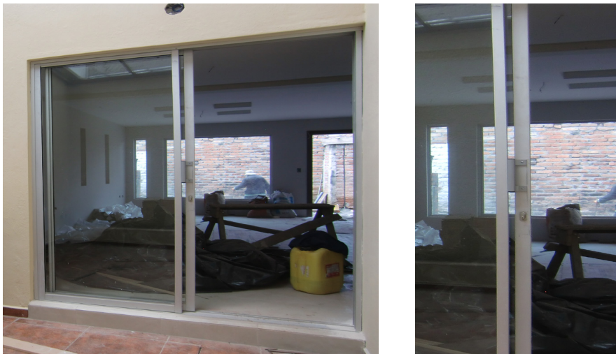
Vistas de espacios diagnosticados, puertas.
