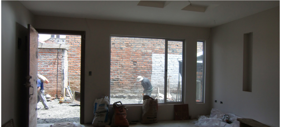
Vistas de espacios diagnosticados, ventanas.
