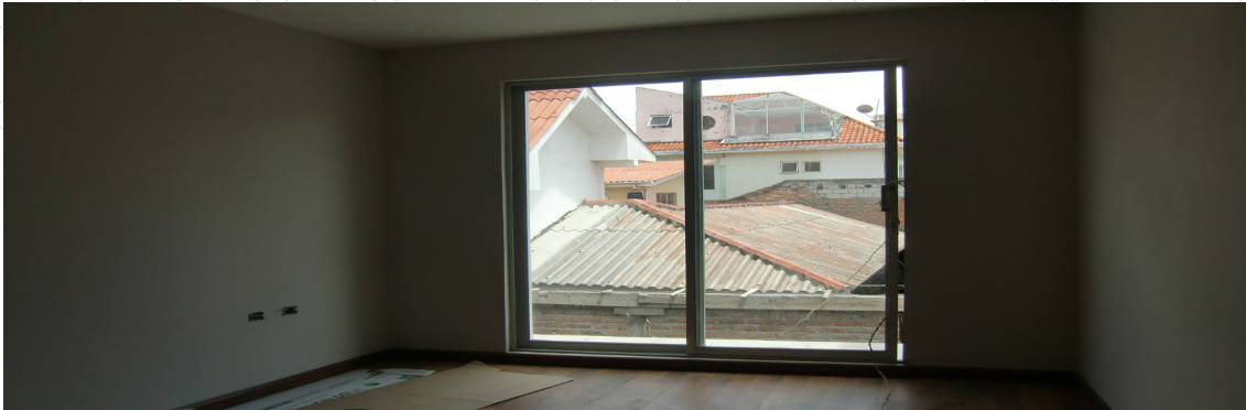
Vistas de espacios diagnosticados, habitaciones.
