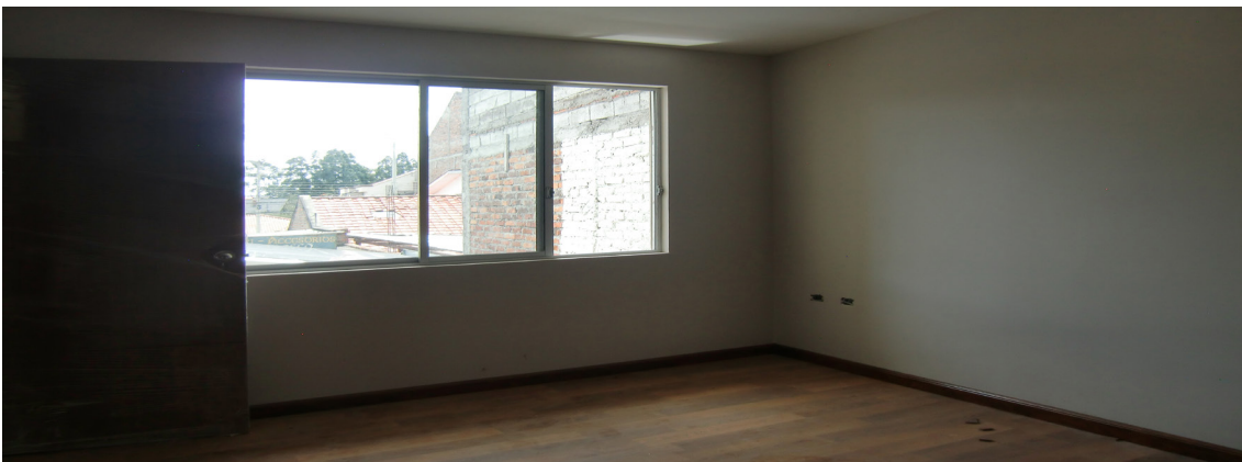
Vistas de espacios diagnosticados, habitaciones.
