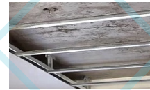
Cielo raso de gypsum y perfiles track, furring, etc.
