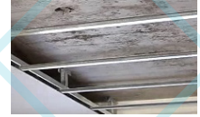
Cielo raso de gypsum y perfiles track, furring, etc.
