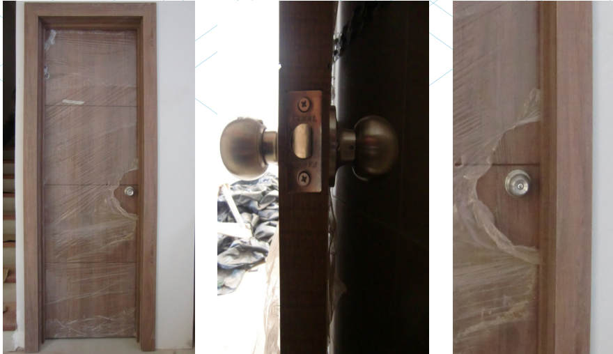
Vistas de espacios diagnosticados, puertas.
