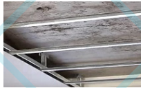
Cielo raso de gypsum y perfiles track, furring, etc.
