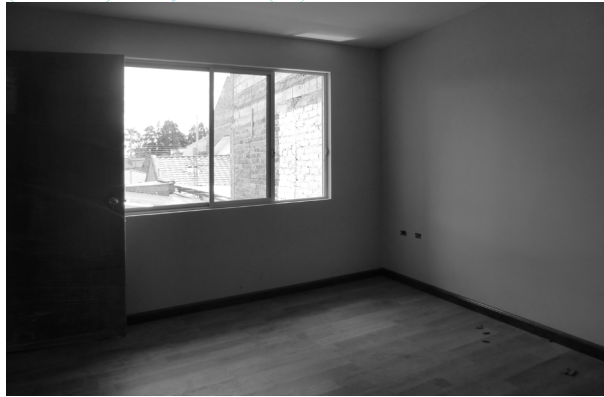
ESTADO ACTUAL Vivienda tipo aledaña
