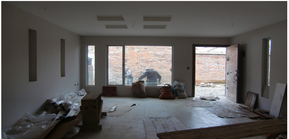
Vista interior hacia el acceso de la vivienda.
