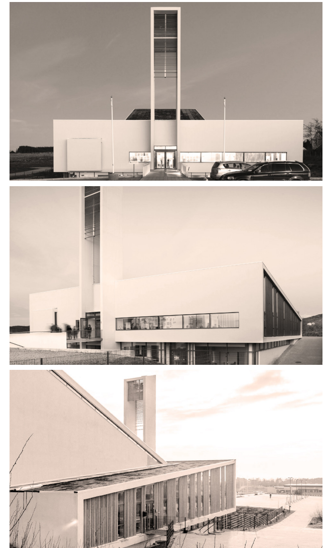
Figura 54. Vistas exteriores, Templo Froeyland
