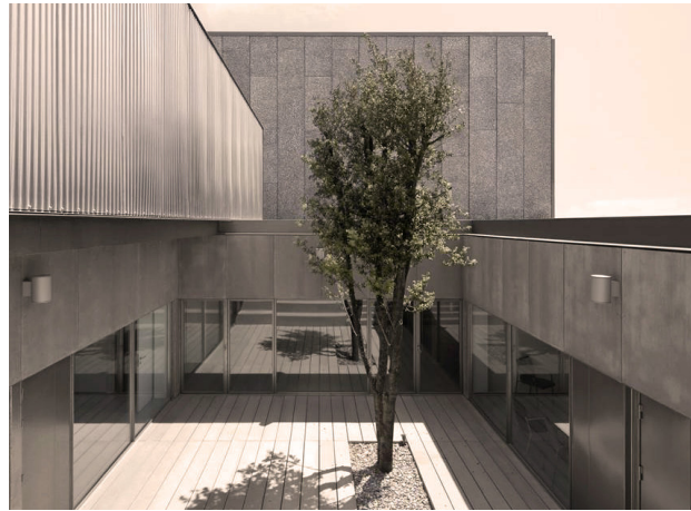
Figura 48. Vista interior desde patio posterior, Iglesia de Terrasa
