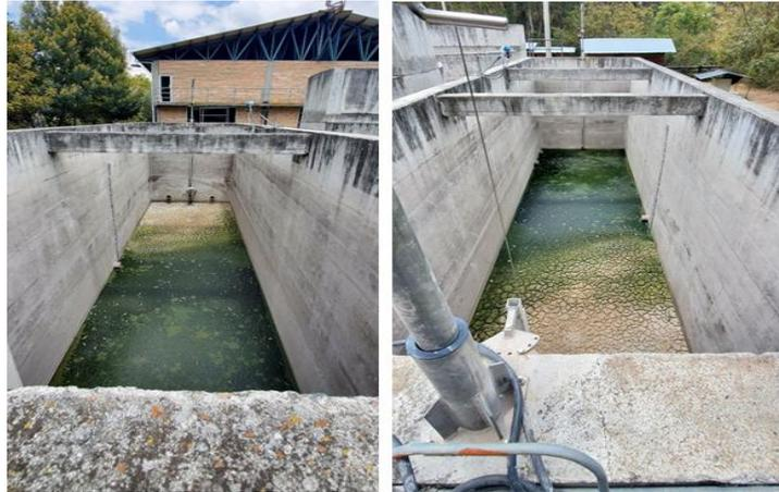
Figura 26: Tanque de almacenamiento de lodos espesados.
