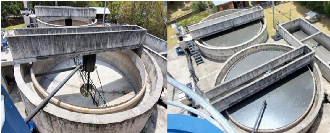
Figura 25: Espesadores conteniendo lodos y vacíos.
