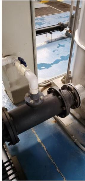
*Figura 17: Punto de convergencia de los caudales de lodos y floculante diluido.*
