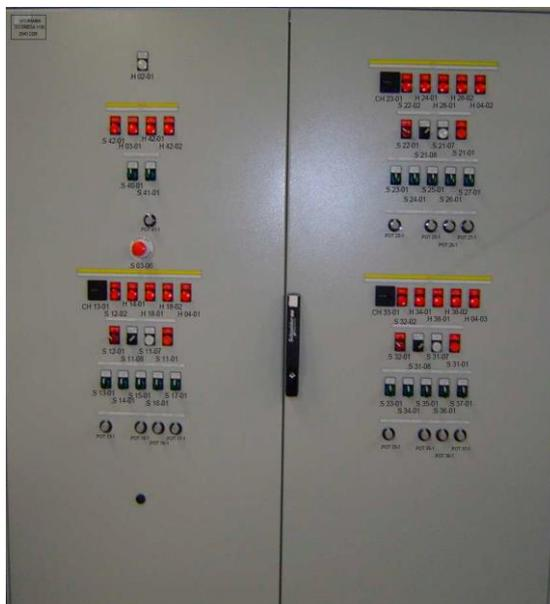
Figura 27: Tablero de control del proceso de deshidratación de lodos.
