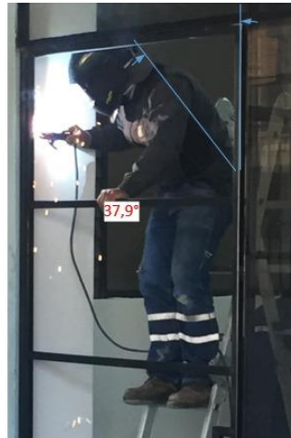
Figura 13: Trabajos de soldadura
