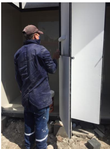
Figura 11: Pintura de paredes
