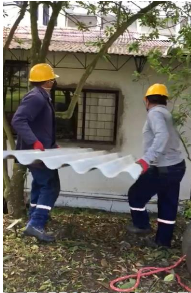
Figura 18: Levantamiento manual de planchas de Eternit
