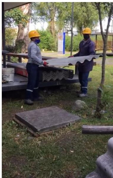
Figura 19: Levantamiento manual de planchas de Eternit
