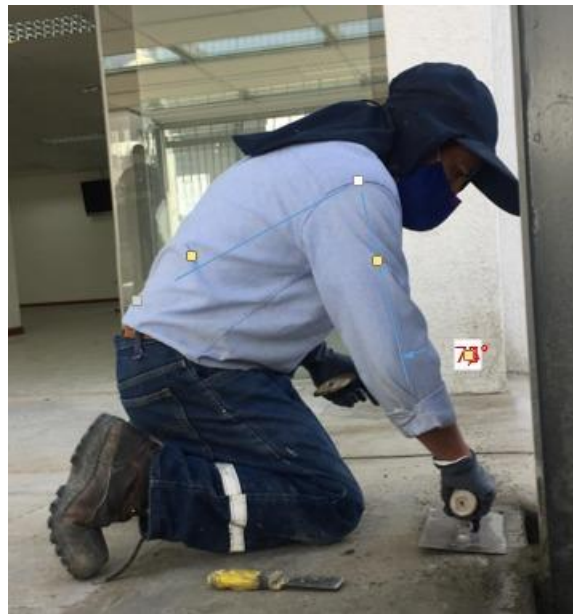
Figura 10: Enlucido de paredes
