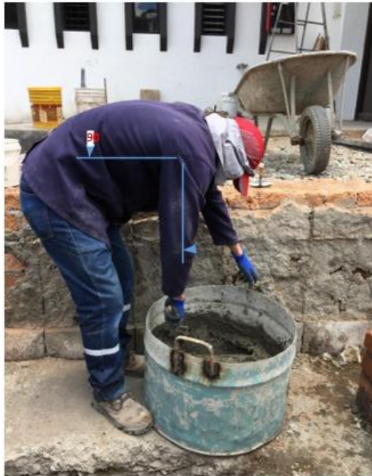
Figura 9: Mezcla de cemento
