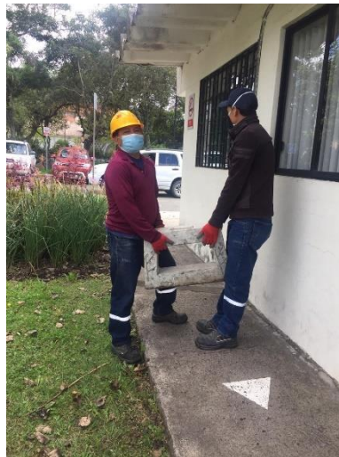
Figura 21: Levantamiento manual de piezas de hormigón
