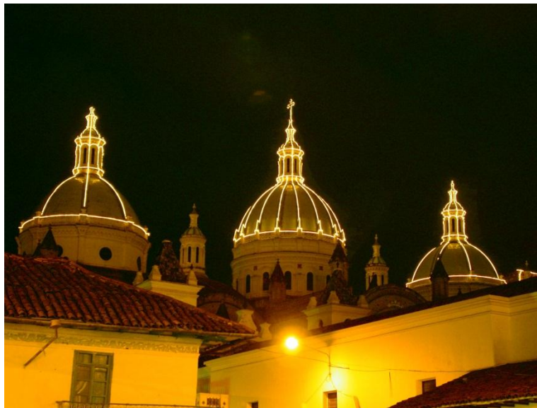
Fig. 3.4 Iluminación Ornamental de la Catedral Nueva, 2004 Fuente: Archivo fotográfico de Ing. Jorge Guapisaca-Constructor
