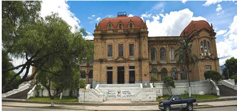
Fotografía de la parte frontal del Colegio Benigno Malo Fuente: Imagen tomada por las autoras
