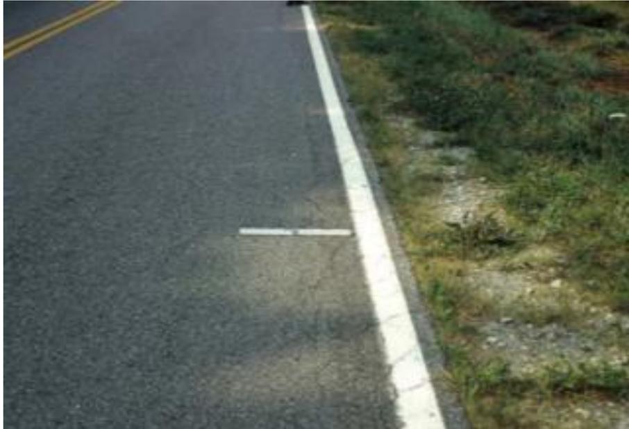
Figura 16: Fisuras de borde (Miller et al., 2014).
