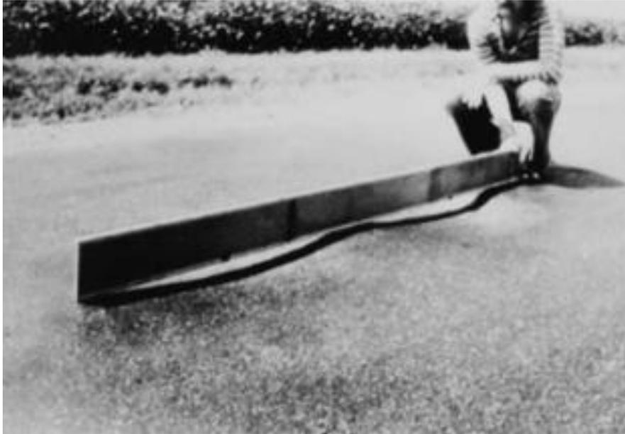
Figura 15: Corrugación (ASTM, 2011).
