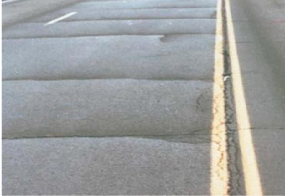
Figura 17: Fisuras de reflexión de junta (Miller et al., 2014).
