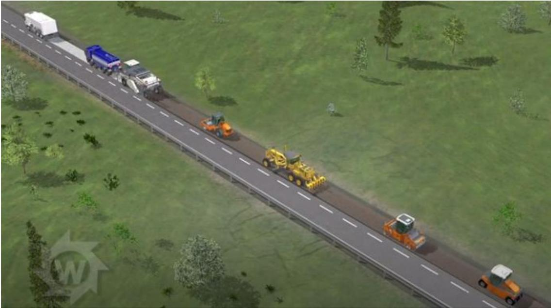
Figura 83: Fresado más estabilización con cemento (Wirtgen, s. f.).
