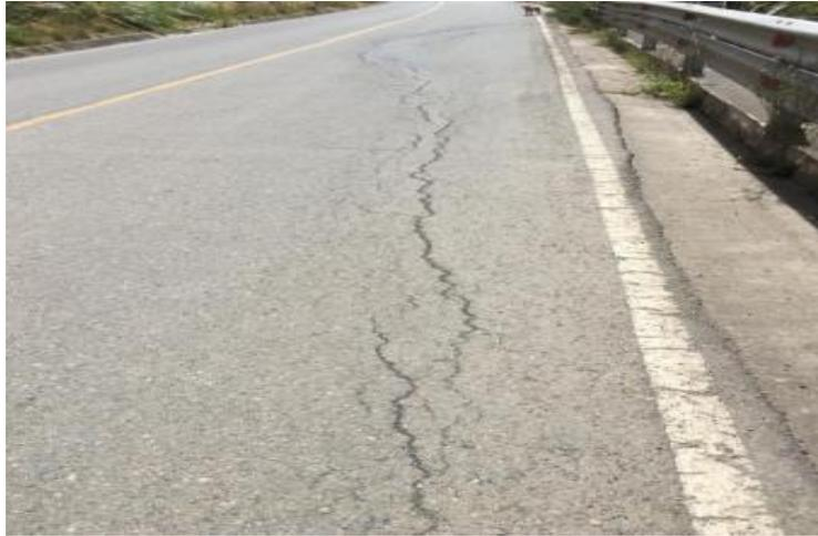
Figura 78: En la abscisa 1+000, se requiere ejecutar actividades de mantenimiento correctivo.
