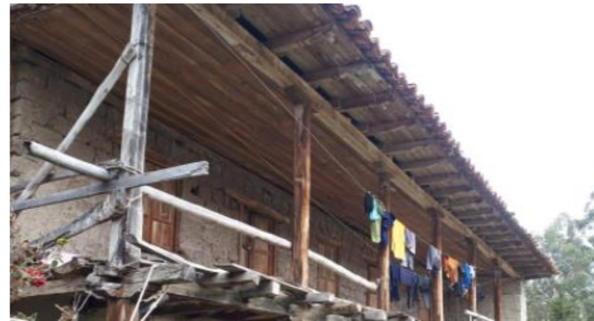
Fotografía3. 29. Cubierta de la vivienda
