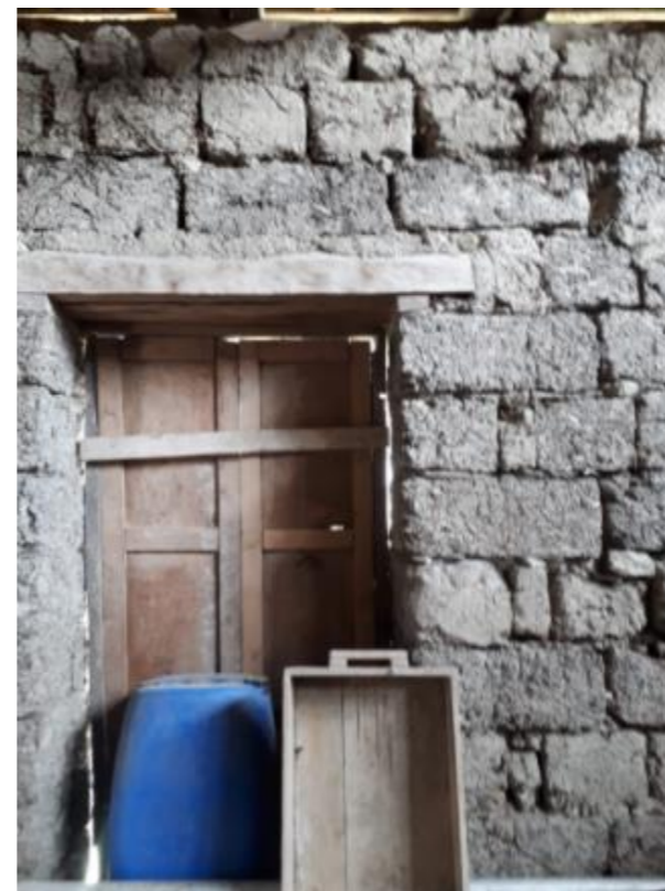
Fotografía3. 30. Muros de la vivienda
