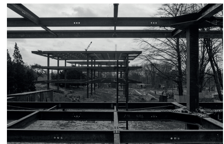
172. Armado del sistema portante
