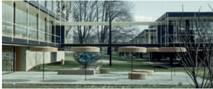
204. Vista hacia el área de descanso exterior del pabellón 8
