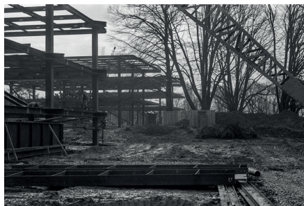
162. Construcción del sistema portante
