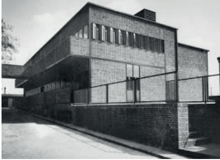
25. Subestación Berlín – Steglitz, 1929-1930
