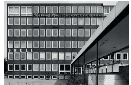
29. Edificio administración de Volkshilfe Lebensversicherung AG, Colonia, 1955-1957
