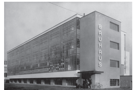
12. Escuela Bauhaus en Dessau 1926, después de la restauración.
