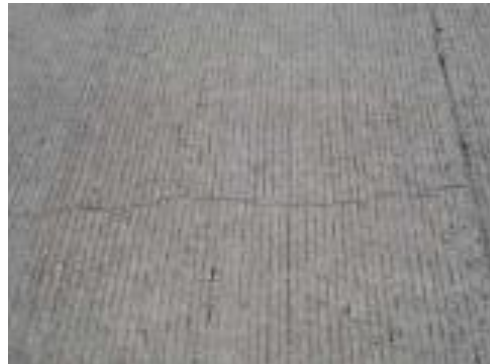
Figura 3.55. Grieta longitudinal.
