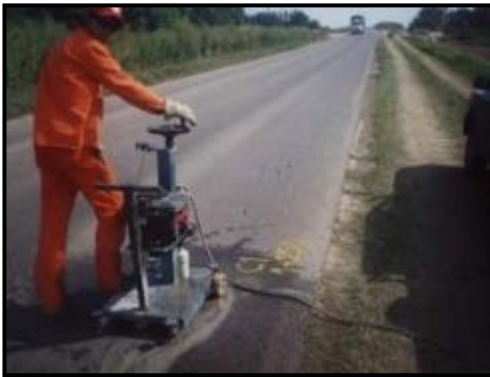
Figura 2.12. Extracción de núcleos. (Corros, Urbáez, & Corredor, 2009)
