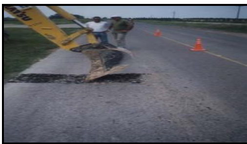
Figura 2.11. Calicata realizada a máquina. (Corros, Urbáez, & Corredor, 2009)
