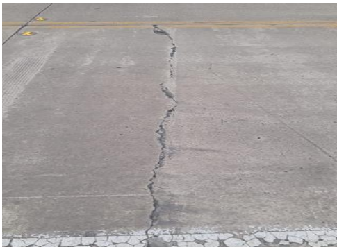
Figura 3.54. Grieta transversal.
