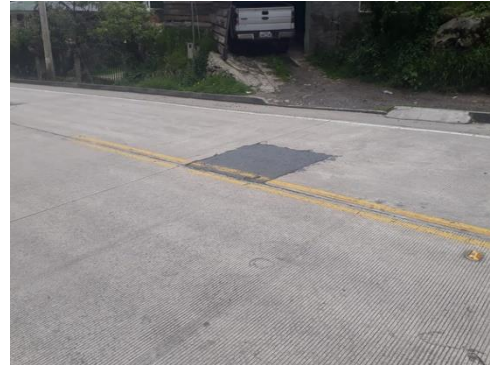
Figura 3.51. Parche asfáltico.
