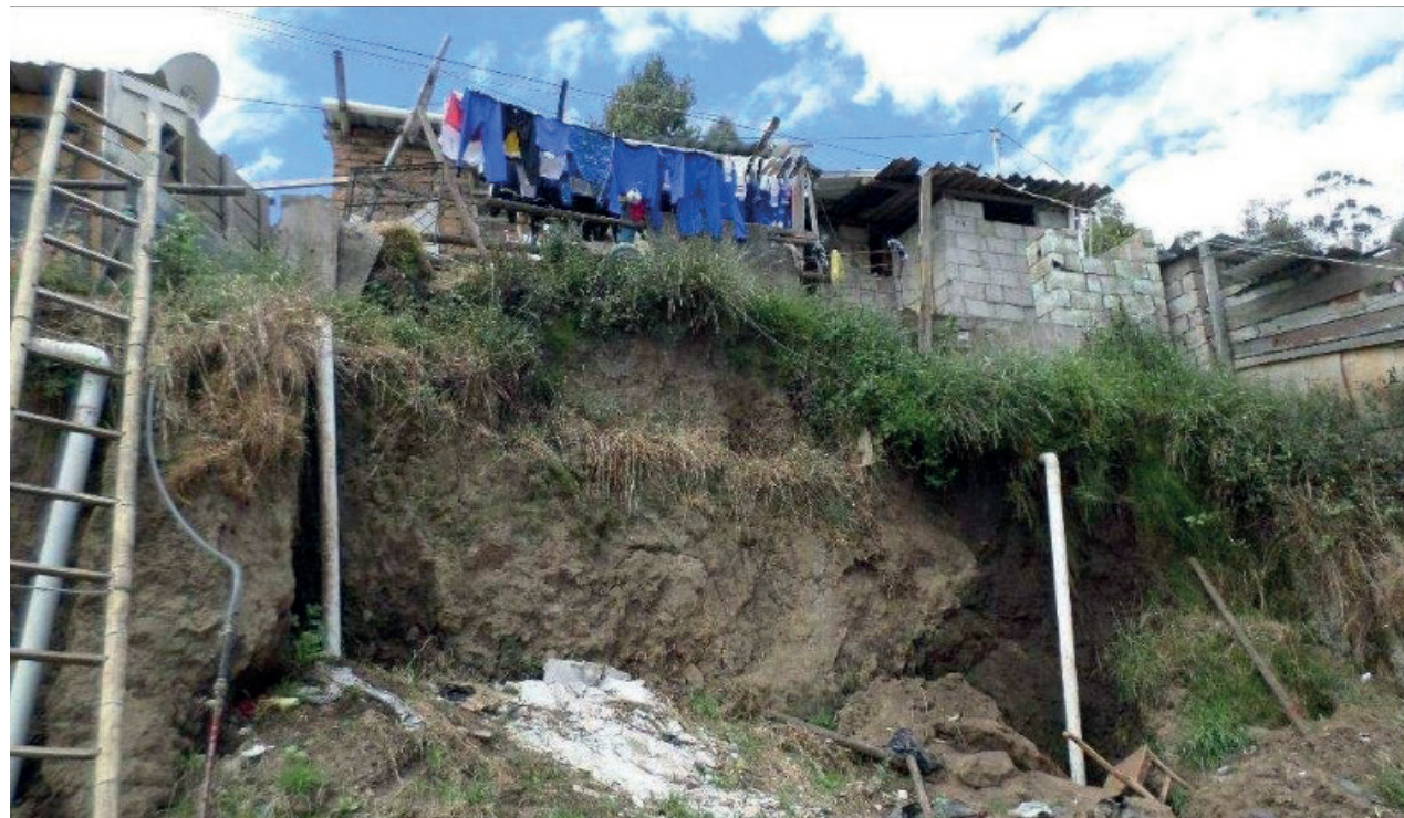
Fotografía 21: Construcciones inadecuadas en suelos inestables, Quito.
