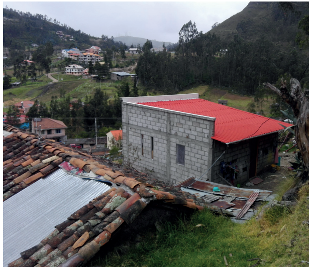
Fotografía 32: Procesos de autoconstrucción en el sector del barrio Guzho-Tres Marías
