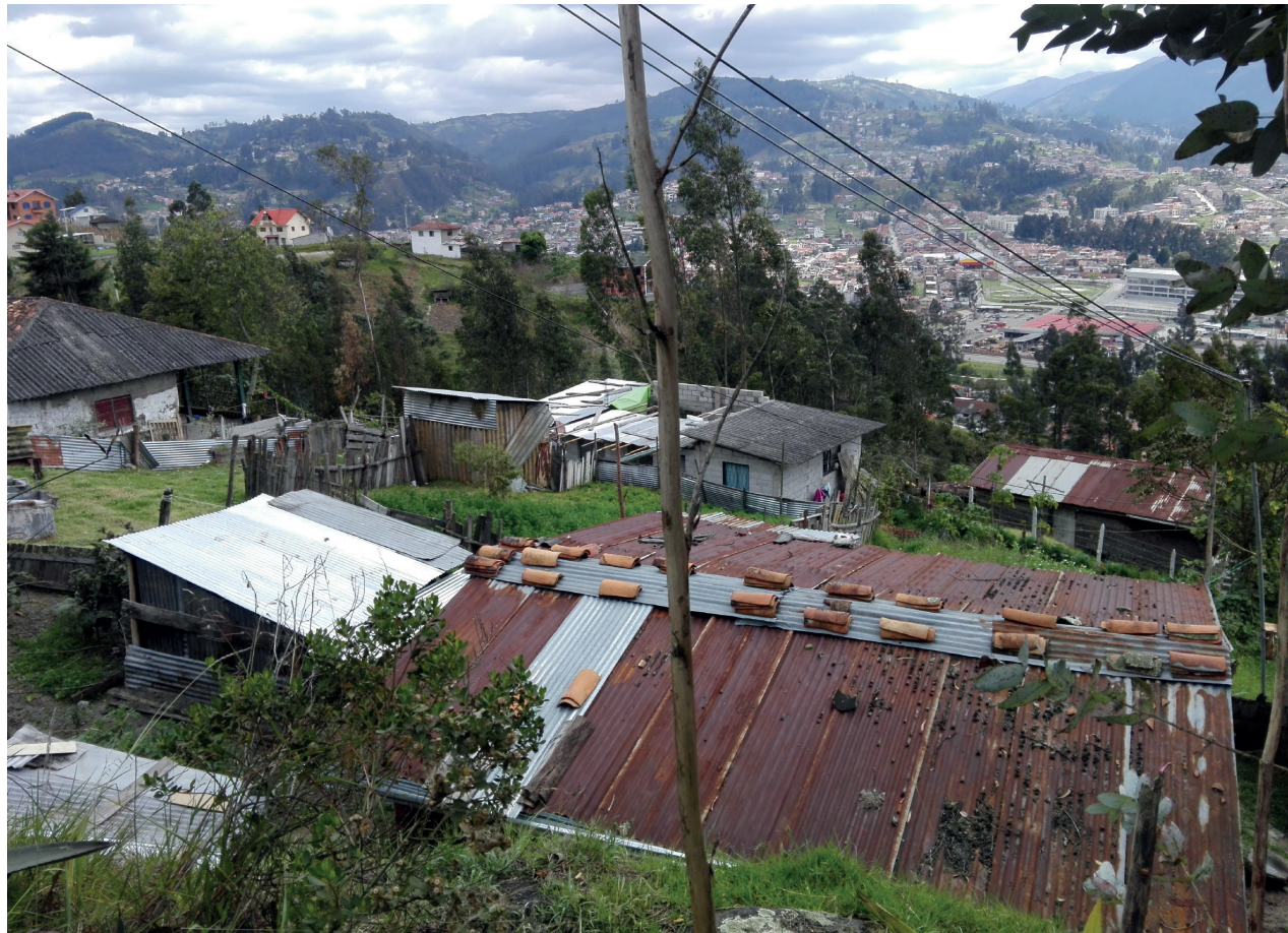
Fotografía 52: Conjunto de viviendas edificadas y en proceso de construcción sin autorización municipal.
