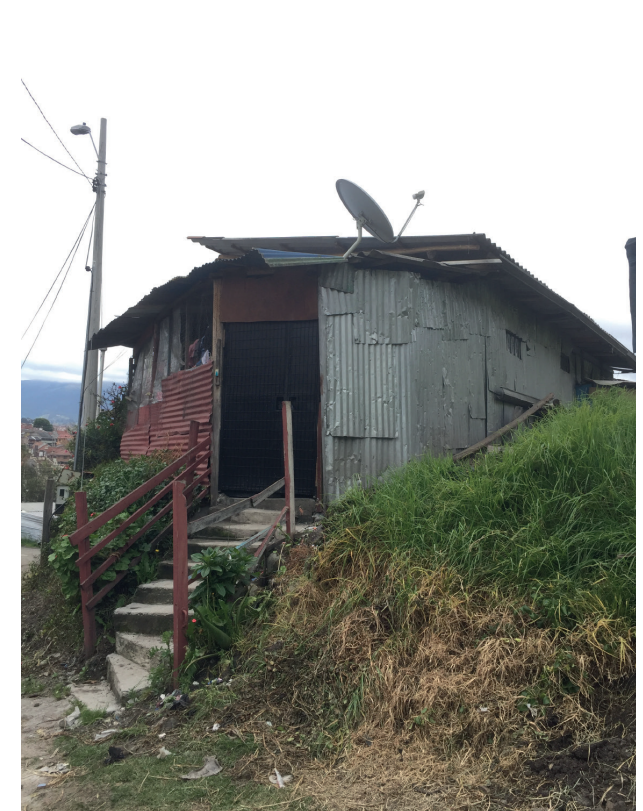
Fotografía 58: Procesos de autoconstrucción de viviendas, sector Guzho-Tres Marías.
