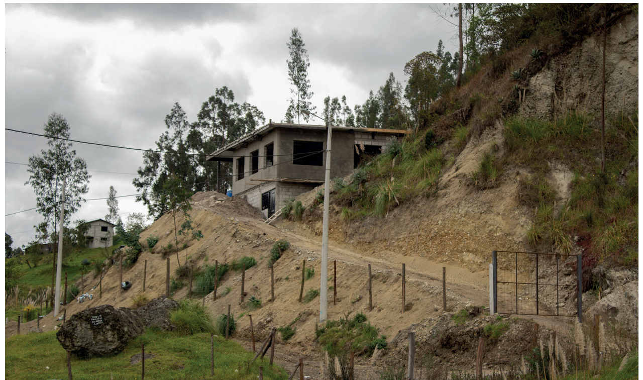
Fotografía 51: Construcción de vivienda en zonas de pendientes pronunciadas.
