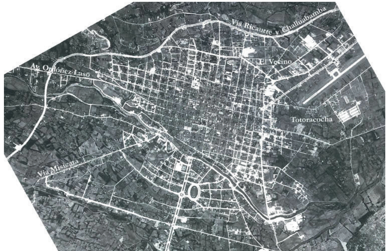
Fotografía 25: Vista aérea de la ciudad de Cuenca (1973).
