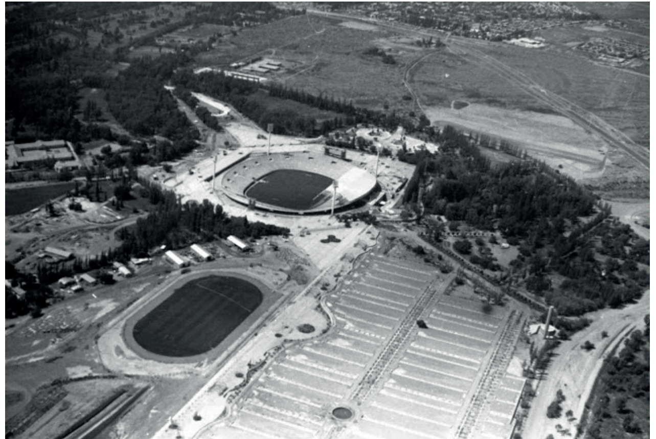
Fotografía 12: Construcción de sede deportiva Mundial de Fútbol Argentina 1978, Mendoza.
