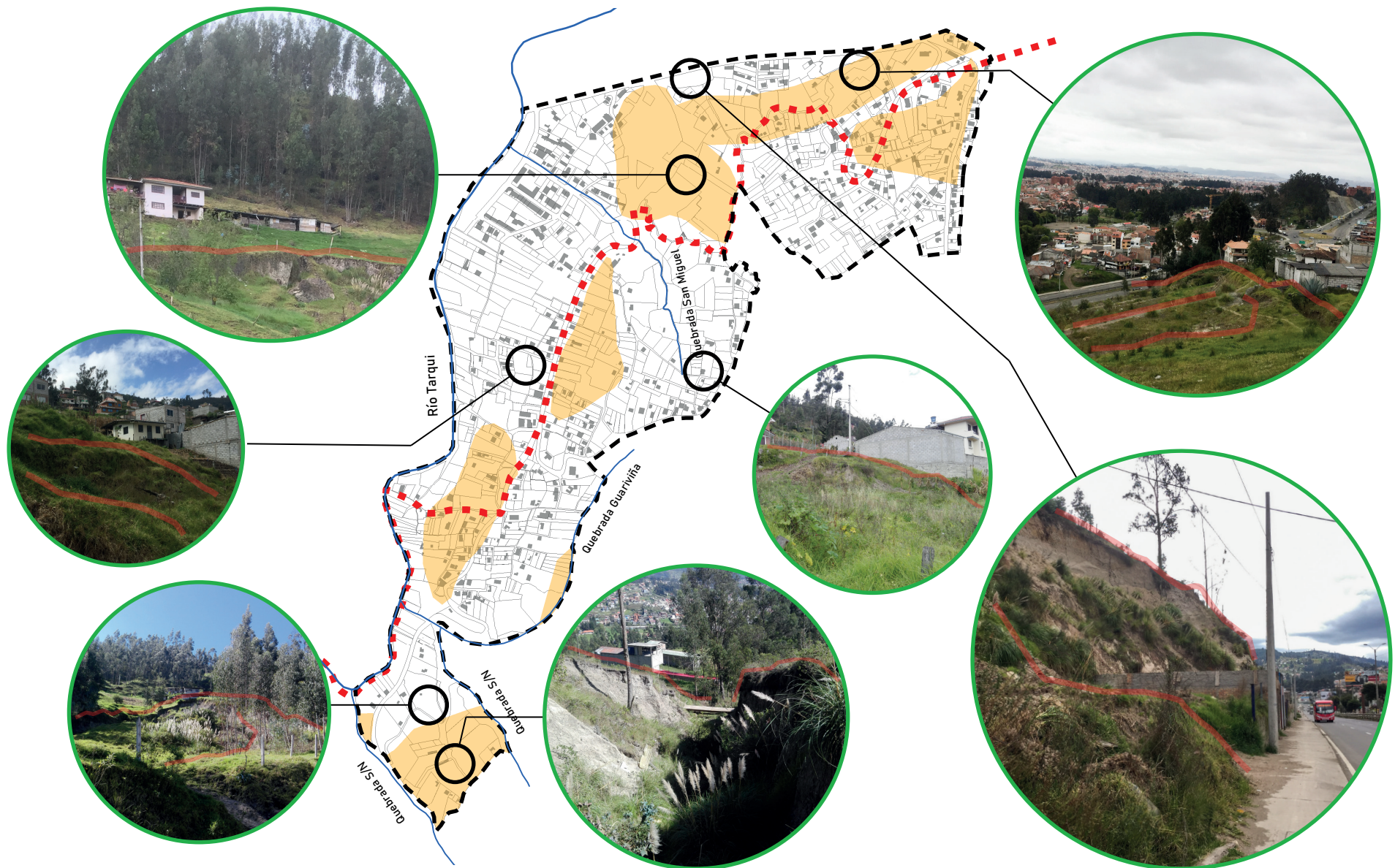
Figura 71: Zonas afectadas por deslizamientos en suelos inestables.
