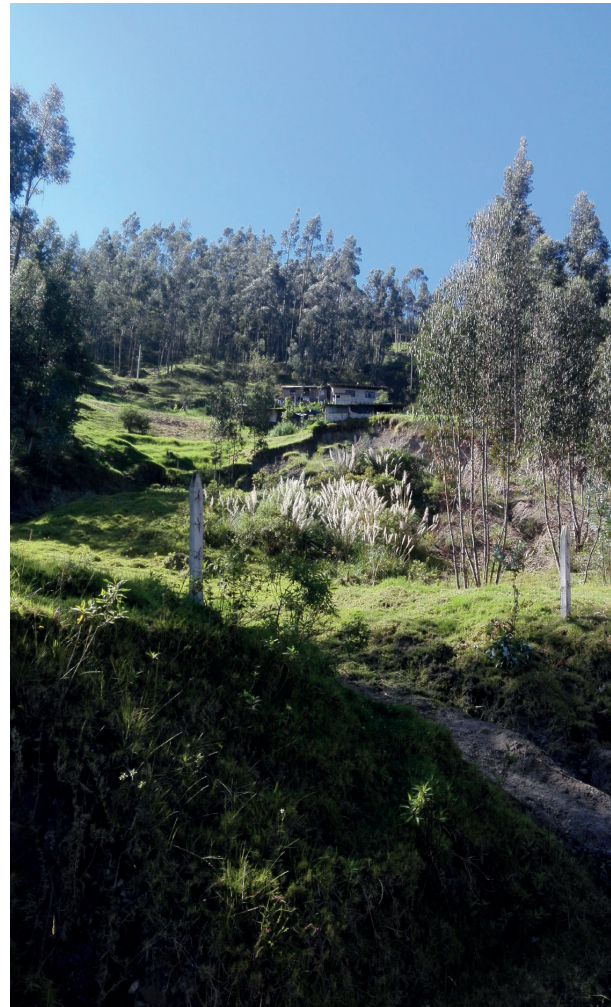
Fotografía 53: Deslizamientos de suelos inestables.
