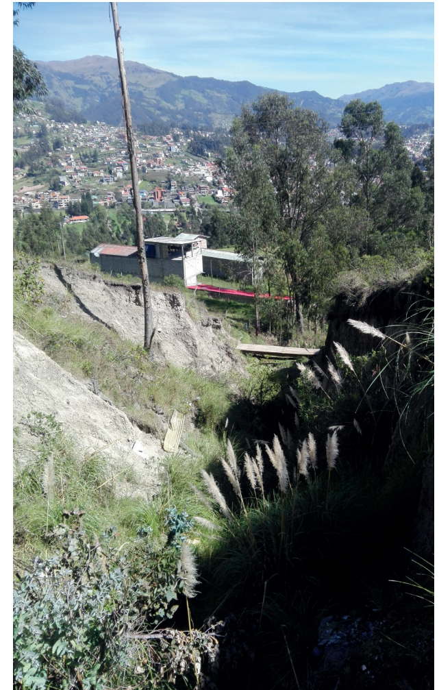
Fotografía 54: Viviendas emplazadas en zonas de riesgo.
