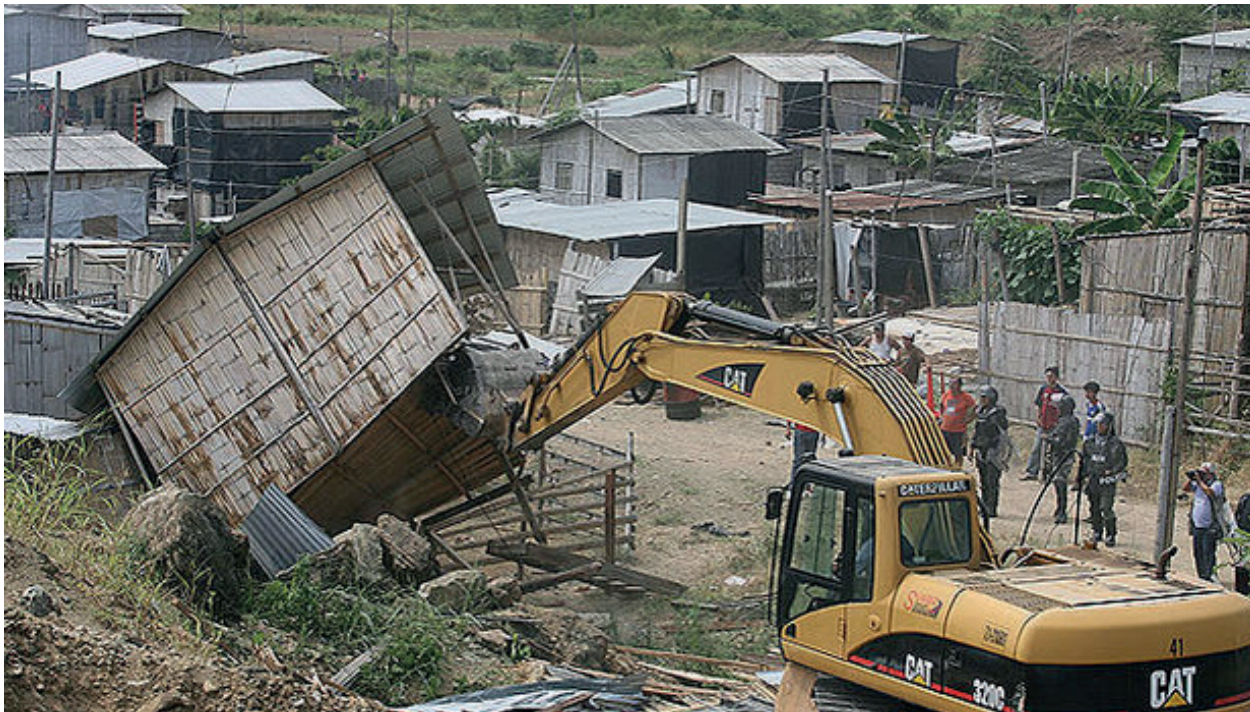
Fotografía 7: Demolición y reubicación de asentamientos informales, Monte Sinai, Guayaquil.
