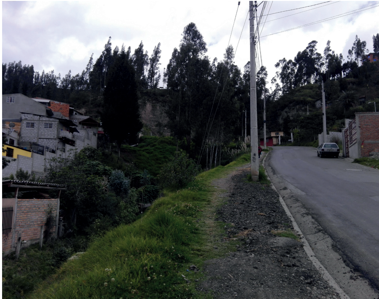
Fotografía 56: Viviendas asentadas dentro de márgenes de protección, sector barrio Guzho-Tres Marías.
