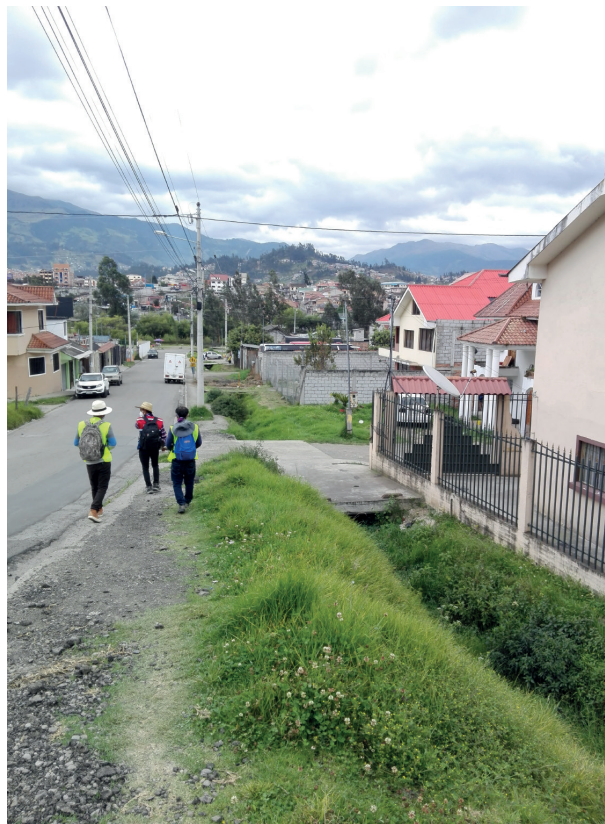
Fotografía 43: Viviendas edificadas sobre el margen de protección de la quebrada "San Miguel", sector Guzho.
