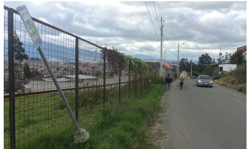
Fotografía 36: Parada de transporte público (Ruta 2) en mal estado, sector El Calvario.
