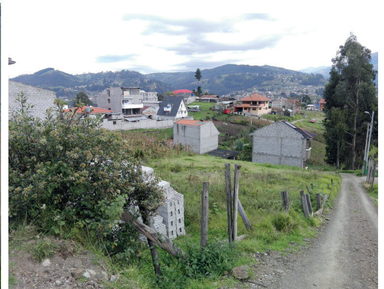
Fotografía 42: Estado actual de predios afectados por deslizamientos en el 2007.
