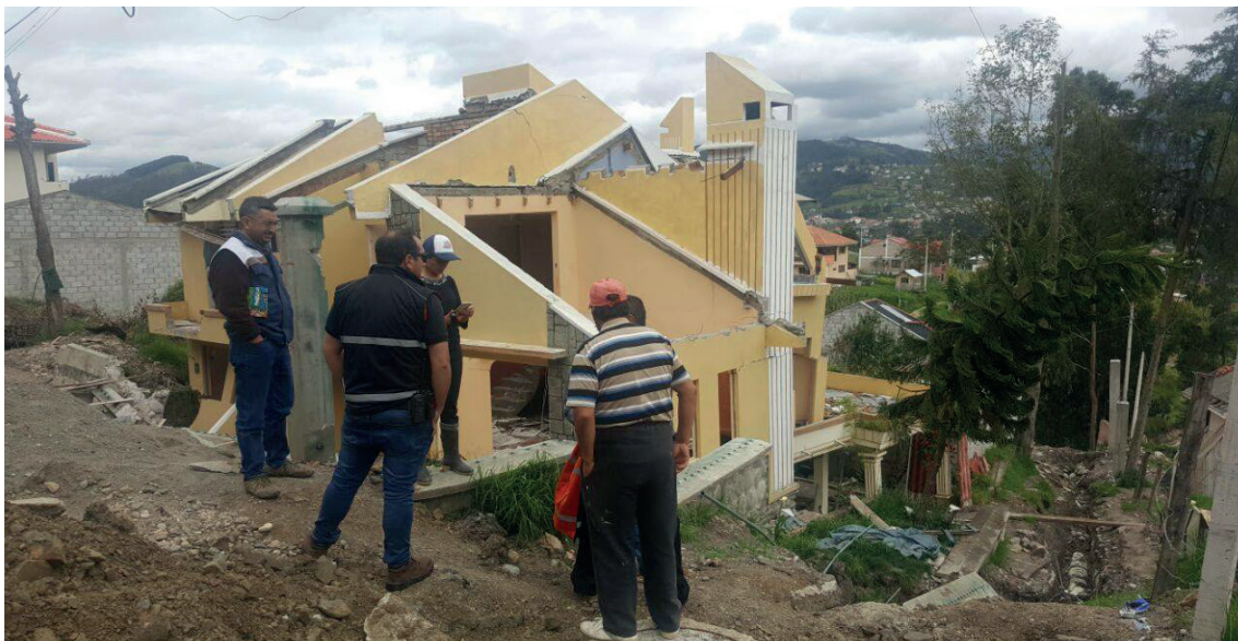
Fotografía 41: Viviendas afectadas por deslizamientos, barrio El Calvario, 2017.
