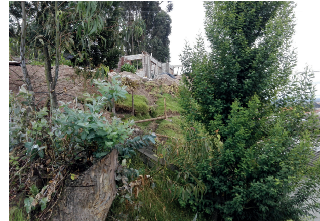
Fotografía 59: Construcción de vivienda sobre suelos accidentados.
