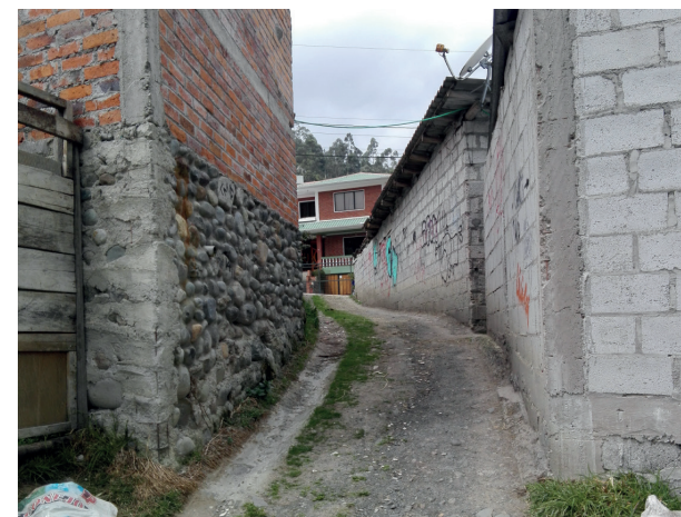
Fotografía 63: Trazo de vías con deficiencias constructivas.
