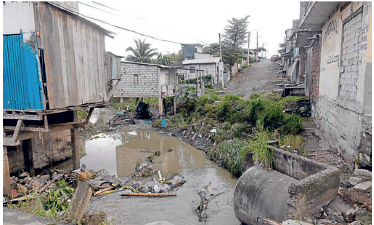
Fotografía 6: Viviendas construidas cerca de un canal abierto en Guayaquil, Ecuador.
