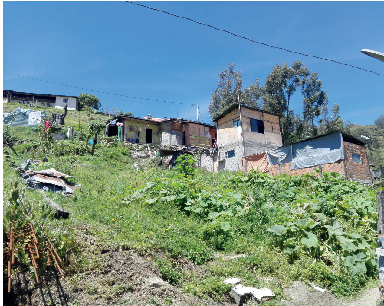
Fotografía 33: Procesos de autoconstrucción en el sector del barrio El Calvario
