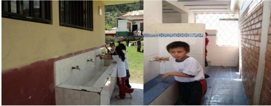
Fotografía N°6.- Baños, grifos de agua de la Escuela Fe y Alegría Fuente: Imagen tomada por Las Autoras.
