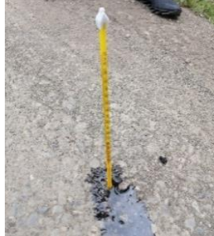
Figura N° 26. Medición de la temperatura del pavimento.
