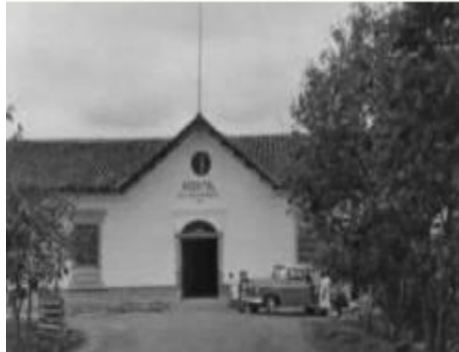
Ilustración 2: Hospital Tres de noviembre Fuente: (Pérez & Sarmiento, 2015, pág.50)
