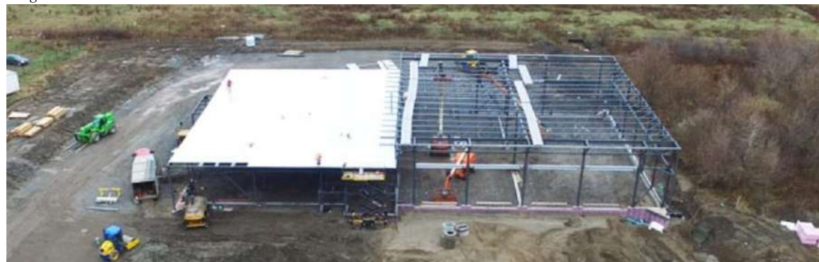
Imagen 2.66 Proceso de construcción: Colocación de cubierta
