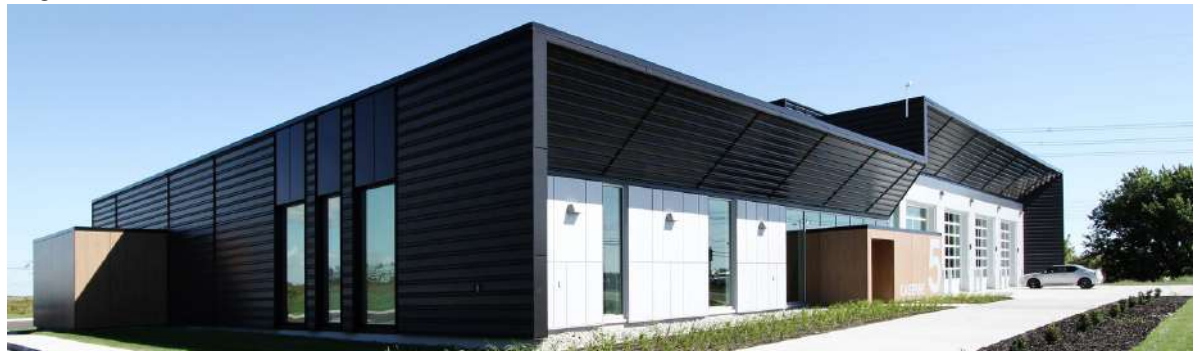
Imagen 2.68 Paneles de aluline en fachadas
