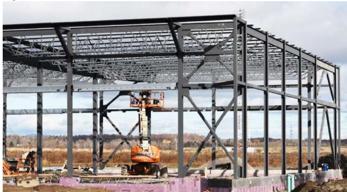
Imagen 2.65 Proceso de construcción
