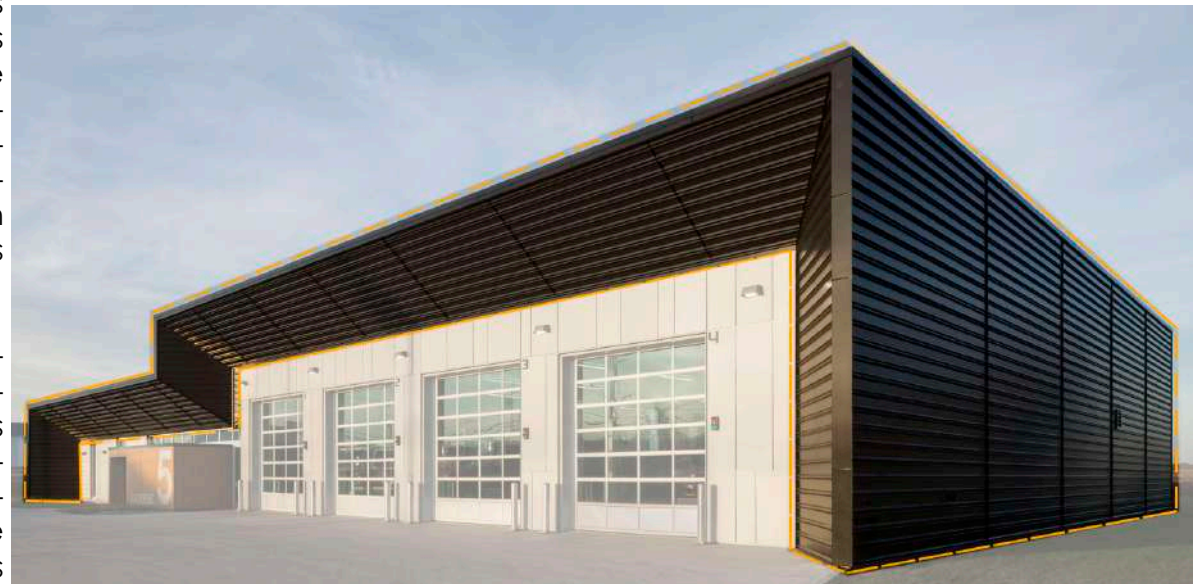
Imagen 2.70 Análisis de materialidad de fachadas (panel de aluline)
