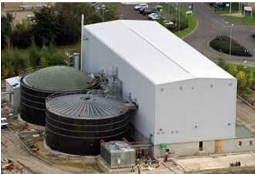
Figura 2.15 Vista aérea de instalación con batería de flujo redox vanadio [21]
