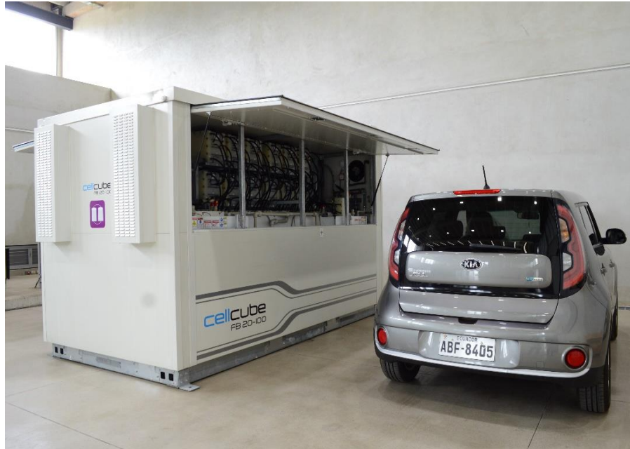
Figura 2.7 FB 20-100 de la casa Gidemeister, potencia 20 kW capacidad de almacenamiento 100 kWh Laboratorio de micredes de la Universidad de Cuenca. (Fuente: Elaboración propia)
