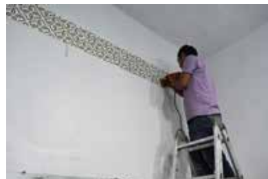
Imagen 24. Aplicación de la cenefa en vinil dorado troquelado, en la parte superior de las paredes laterales del local. Autor: Katherine Cordero
