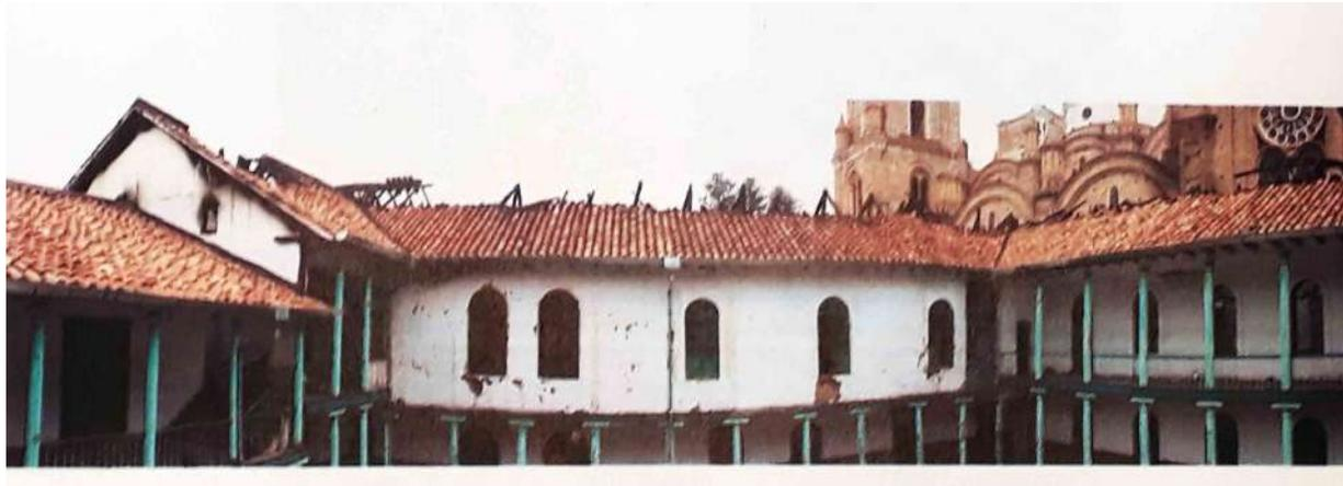
**Fig. 173.** Estado del inmueble después del incendio
