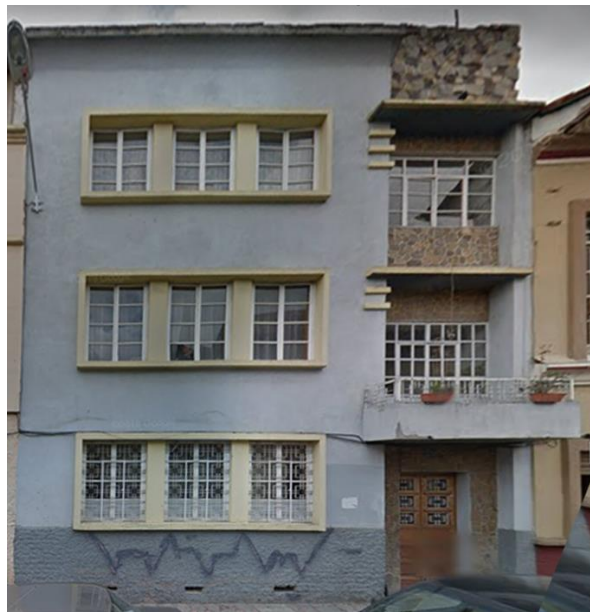
Figura 3.5 Casa Donoso-Guzmán ubicada en la Calle Mariscal Sucre 12-83 (Cuenca - Ecuador)
