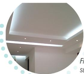
Figura 55. Cielo raso suspendido
