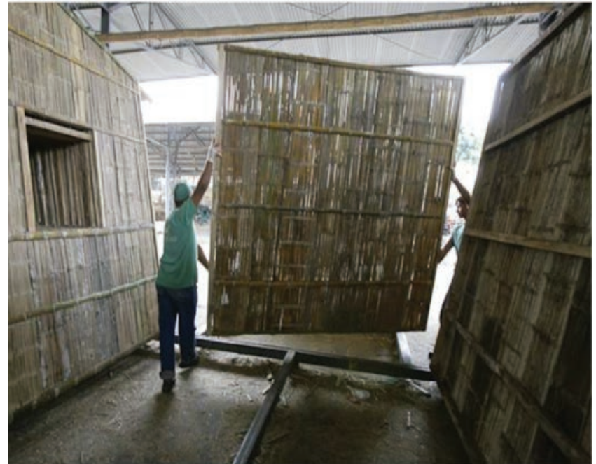
Imagen 2.2 Transporte y montaje de piezas de las viviendas Hogar de Cristo
