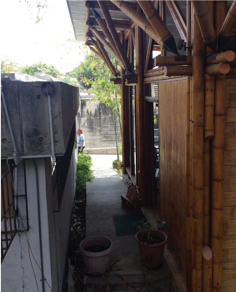
Imagen 7.2.c Alero del Centro de documentación de Bambú, UCSG.
