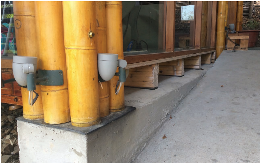
Imagen 7.2.a Cimentación Centro de documentación de Bambú, UCSG.
