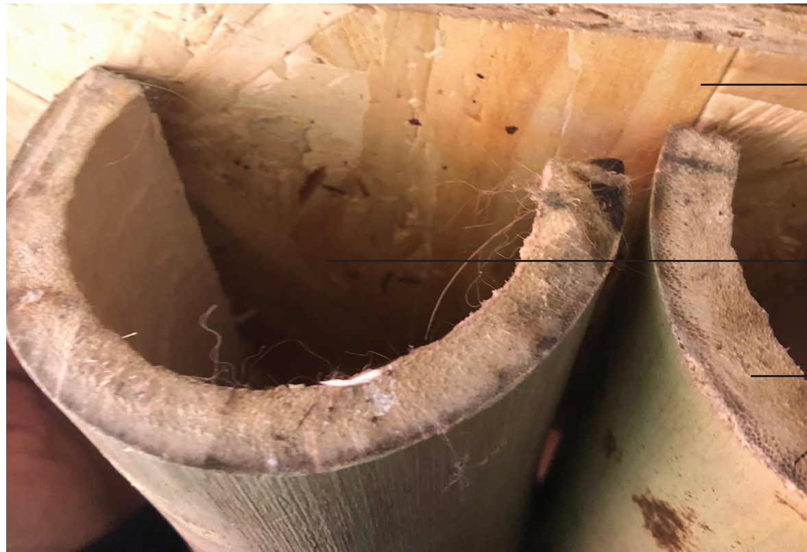
Imagen 3.4.2.c Detalle de espacios para instalaciones
