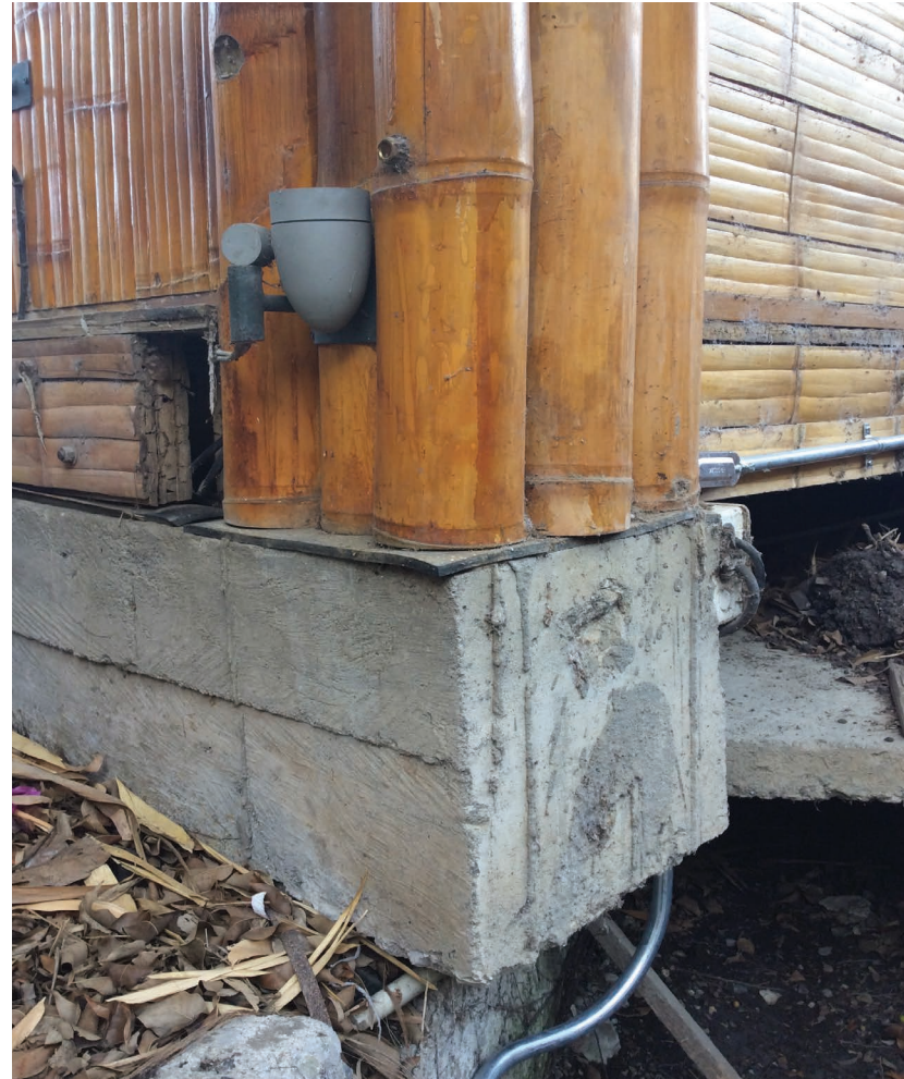
Imagen 7.2.b Cimentación Centro de documentación de Bambú, UCSG.
