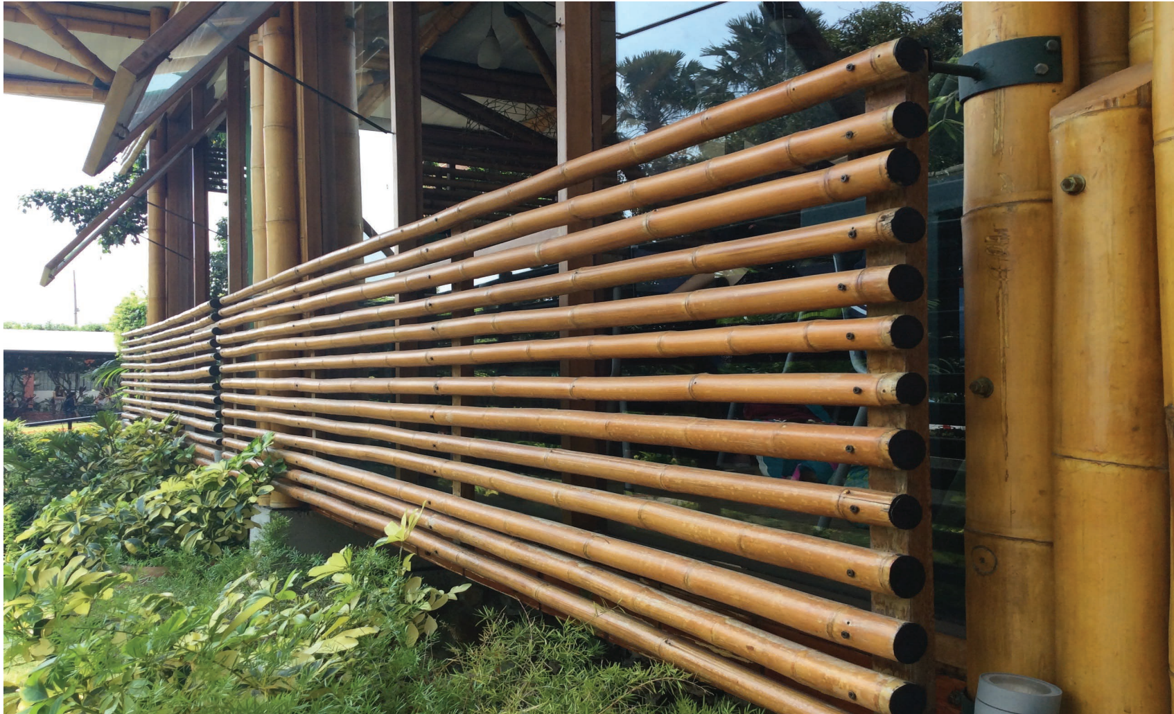
Imagen 7.2.j Detalle del cerramiento de la parte frontal del Centro de documentación de Bambú, UCSG.
