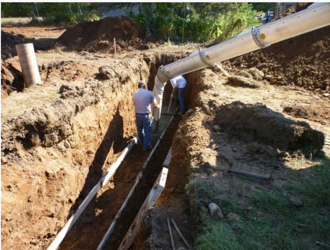
Imagen 48. Zanja de Cimentación - Cabaña Tin Cam.
