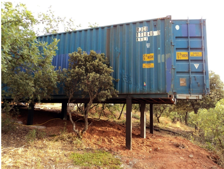
Imagen 60. Montaje de los Contenedores.
