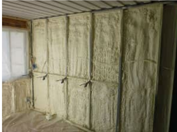
Imagen 55. Recubrimiento con Aislante - Cabaña Tin Cam.
