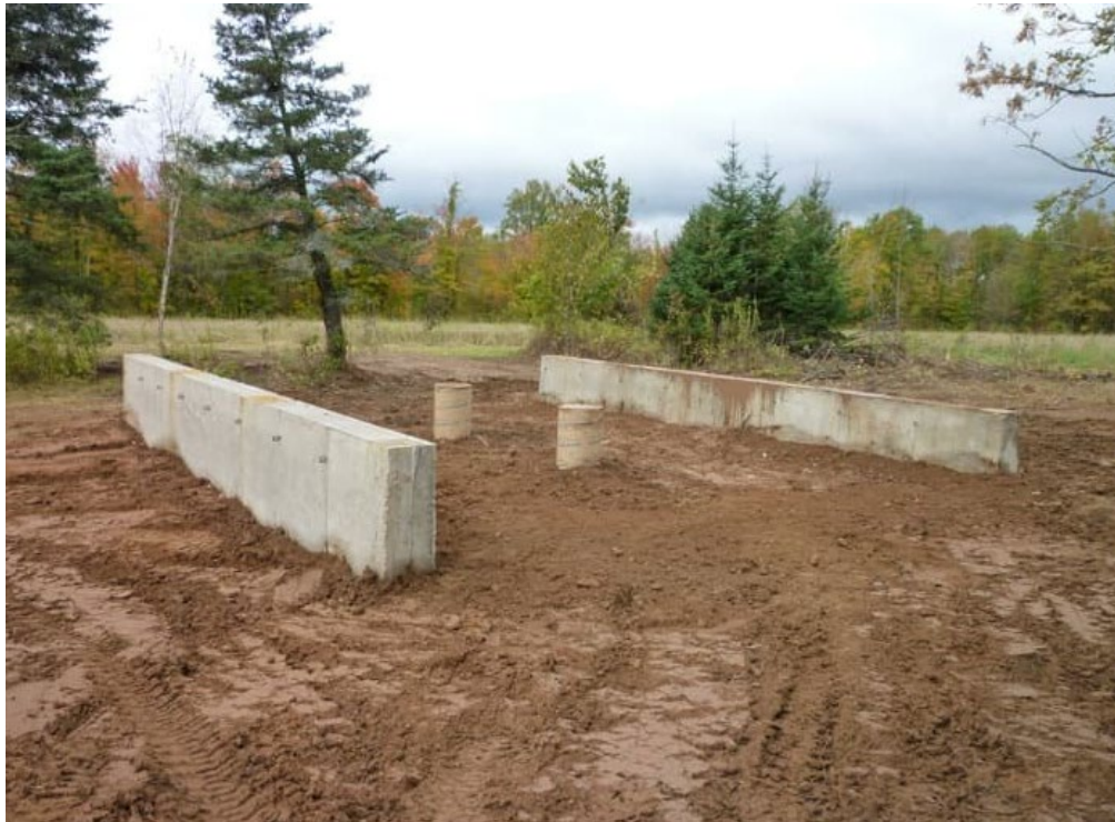
Imagen 49. Cimentación - Cabaña Tin Cam.
