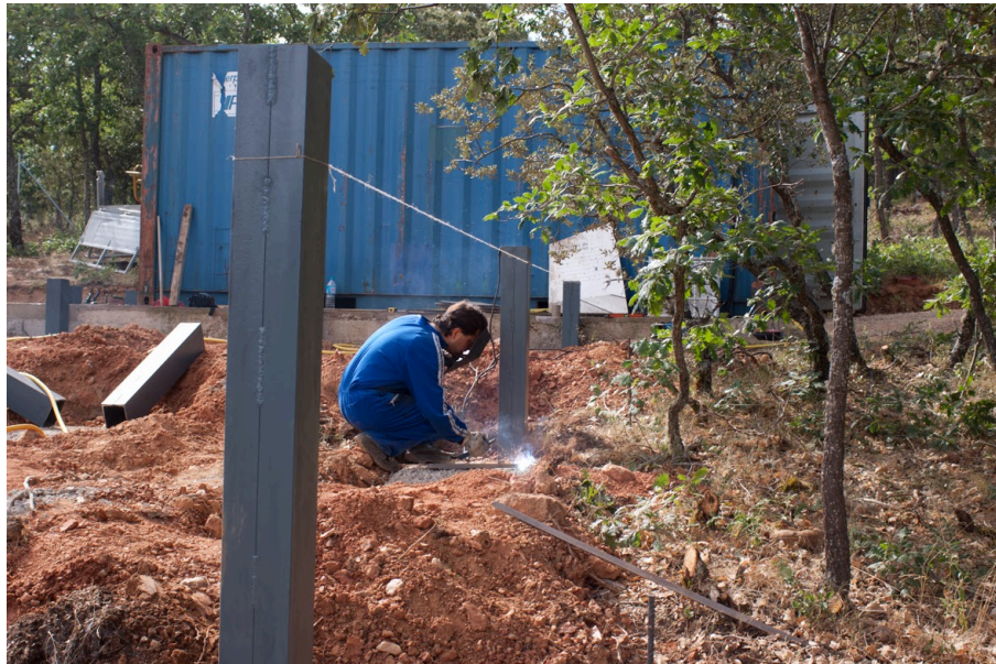
Imagen 59. Zapatas y Columnas Metálicas.
