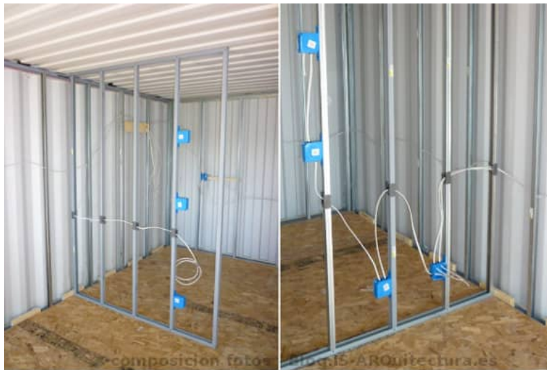
Imagen 54. Marcos Metálicos y Cableado para Instalaciones Eléctricas.
