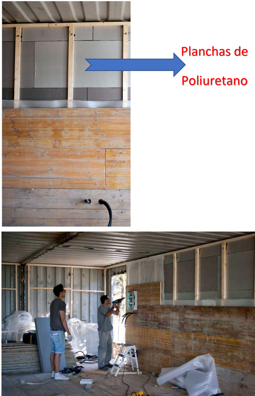
Imagen 63. Colocación de Planchas de Poliuretano.
