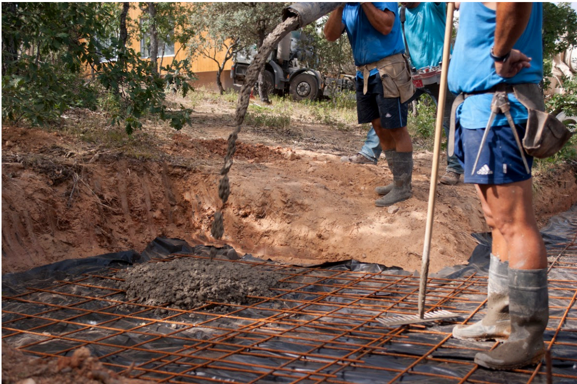
Imagen 57. Armado de Losa de Fundición.
