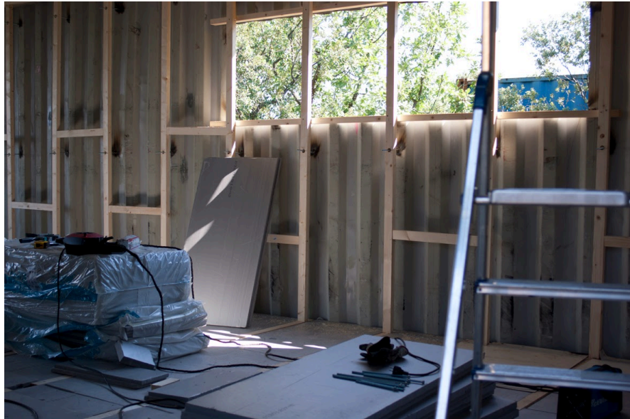
Imagen 62. Construcción de los Bastidores de Madera en los Contenedores.
