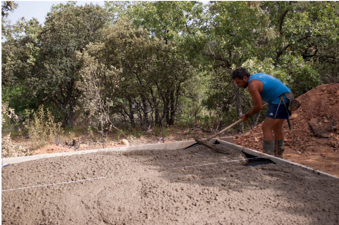
Imagen 58. Losa de Fundición.
