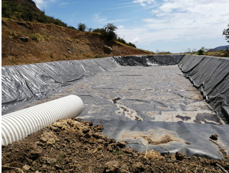
Ilustración 18. Reservorio Santa Marta.
