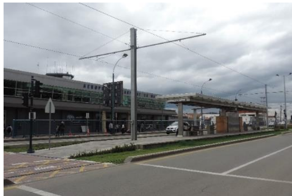
Figura 3.8. Alimentación del Tranvía mediante tecnología LAC.
