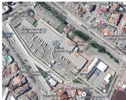
Figura 6.18. Vista de las instalaciones de la Estación de Transferencia Terminal Terrestre en la Av. España. Fuente: Propia del Autor.
